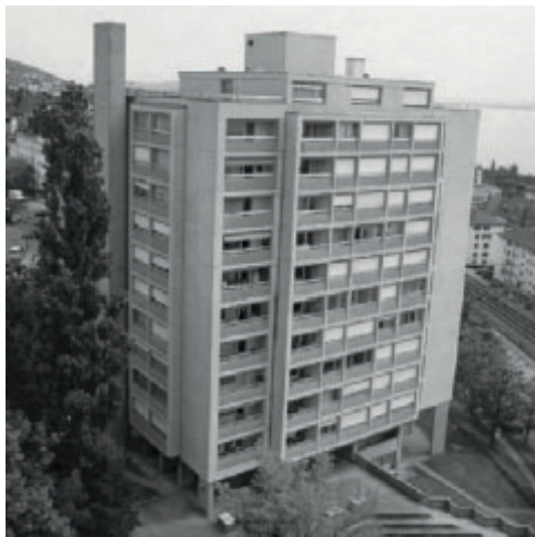
Imagen 2.55: Estado actual edificio residencial año 1972 Fuente: Aguacil et al, 2017.
