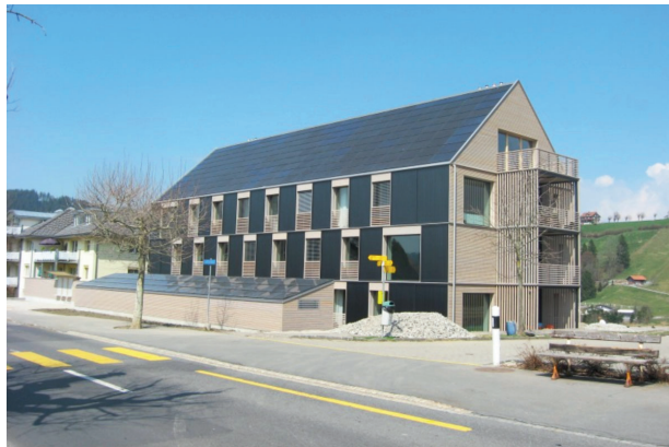
Imagen 2.36: Paneles PVs y CSTs en el edificio Fuente: Reina, 2014.
