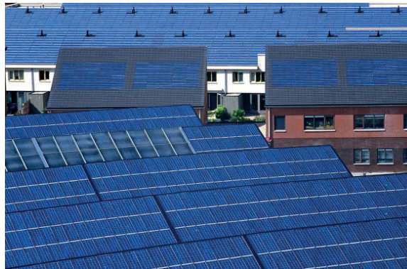
Imagen 2.31: Proyecto 13MW en Amersfoort Nieuwland, Países Bajos. Sistemas fotovoltaicos añadidos visiblemente Fuente: Kaan & Reijenga, 2004.
