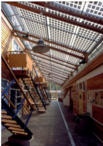
Imagen 2.26: Pasillo interior del centro de información ambiental "De Kleine Aarde en Bortel", Países Bajos. La instalación fotovoltaica contribuye al interior atractivo Fuente: Muñoz, 2009.
