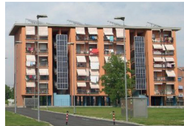
Imagen 2.47: Paneles PVs instalados en el edificio Fuente: Lobaccaro, Lindkvist, & Wall, 2018.
