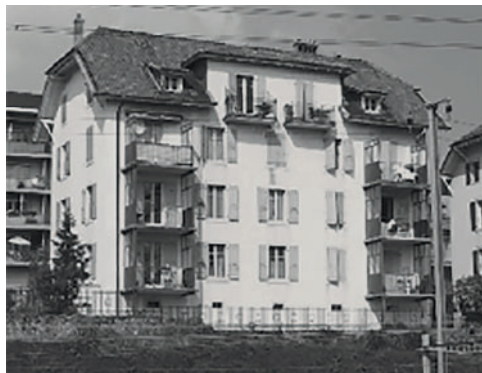
Imagen 2.54: Estado actual edificio residencial año 1909 Fuente: Aguacil et al, 2017.
