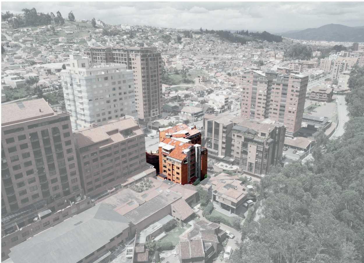
Imagen 3.08: Vista posterior del contexto del edificio Pinar del Lago I
