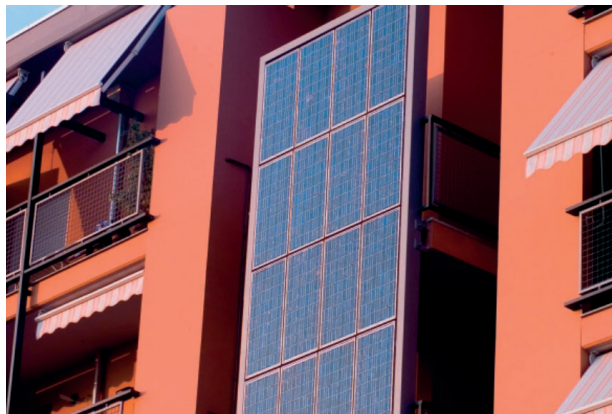
Imagen 2.49: Sistema modular, paneles PVs instalados en la fachada de edificio de Alessandria Fuente: Lobaccaro, Lindkvist, & Wall, 2018.
