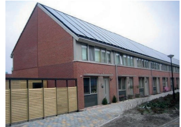
Imagen 2.33: Proyecto 5MW en Langedijk, Países Bajos, casas con un gran techo que se encuentra totalmente cubierto de módulos PVs, sin perforaciones de drenaje Fuente: Agentschap, 2010.
