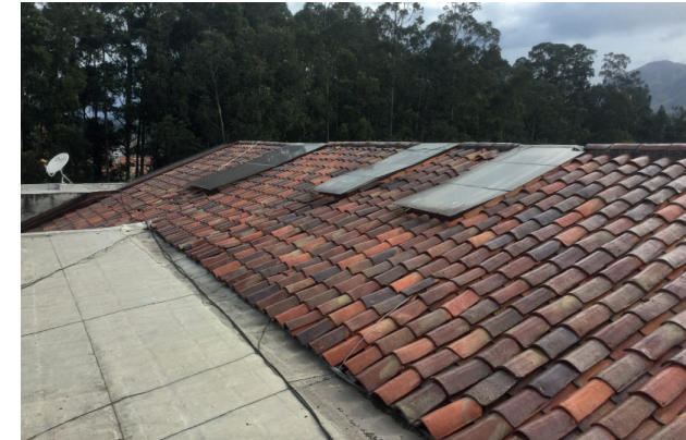
Imagen 3.16: Cubierta del edificio multifamiliar
