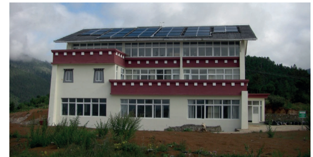
Imagen 2.34: Cubiertas provistas de una construcción de acero que se ajusta sobre las casas Fuente: Agentschap, 2010.
