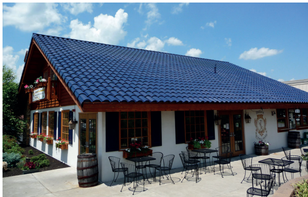
Imagen 2.16: Ejemplo de casa con cubierta BIPV Fuente: Garrido, 2011.
