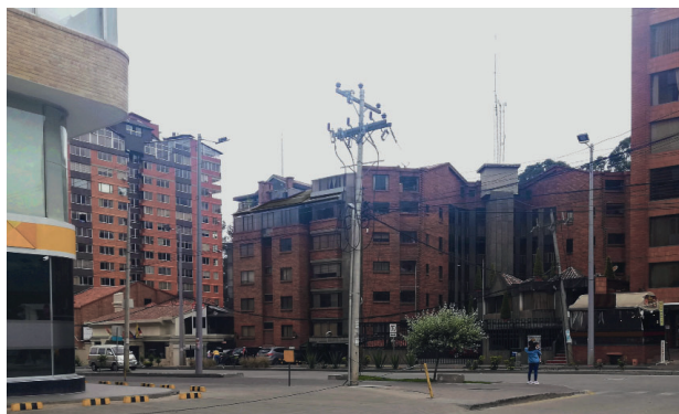
Imagen 4.46: Edificio Pinar del Lago con paneles sin contactos metálicos en la cubierta. Fotografía tomada desde la calle De las Higuerrillas (P1)
