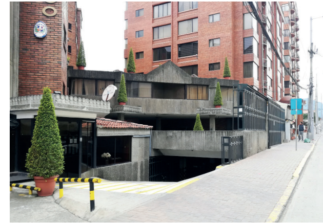
Imagen 3.15: Acceso a los parqueaderos del Edificio
