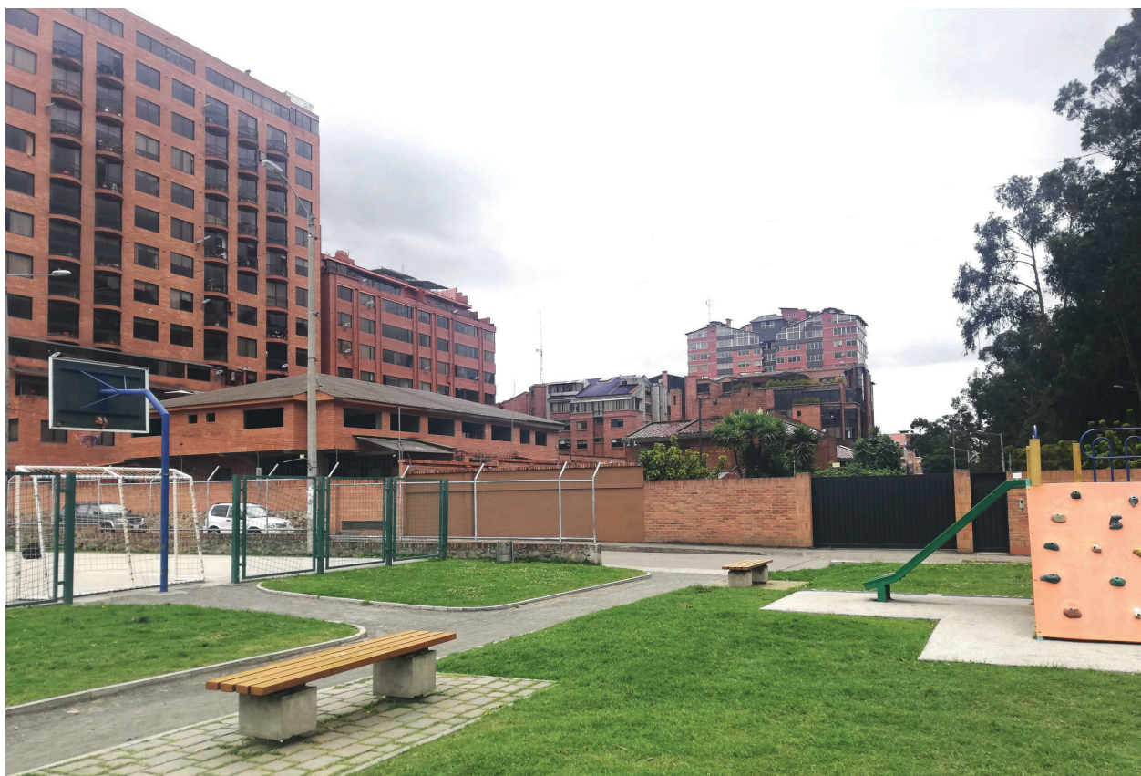
Imagen 4.48: Integración de paneles de sílice monocristalino en la cubierta del edificio. Fotografía tomada desde el parque Virgen del Milagro (P3)
