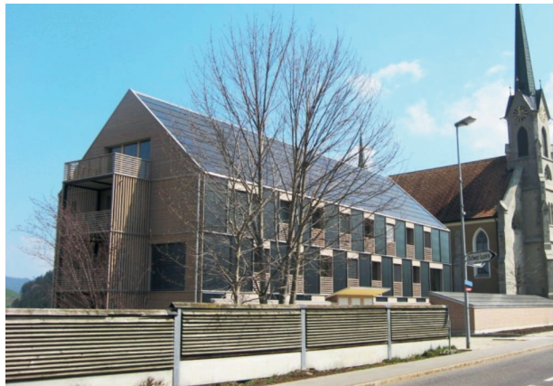
Imagen 2.35: Edificio Kraftwerk B junto a la iglesia Sebastián Fuente: Reina, 2014.
