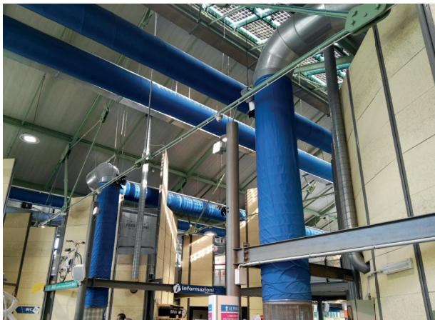
Imagen 2.29: Museo de los Niños, Roma, Italia, con un sistema fotovoltaico integrado en la protección solar Fuente: Google Maps, 2019.
