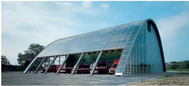
Imagen 2.25: Estación de Bomberos en Houten, Países Bajos. Paneles transparentes han sido fijados en el techo curvado Fuente: Echeverría, 2011.
