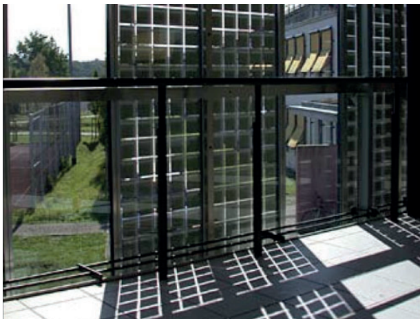
Imagen 2.21: Ejemplo de Fachada fotovoltaica utilizando módulos semitransparentes Fuente: Muñoz, 2009.
