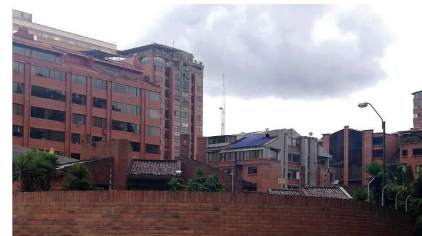
Imagen 4.50: Integración de paneles de sílice monocristalino en la cubierta. Fotografía tomada desde la calle Paseo 3 de Noviembre (P4) Fuente: Autores.
