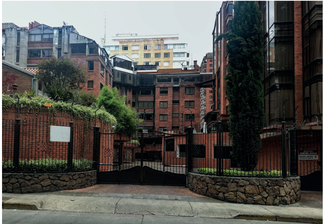
Imagen 4.52: Apreciación de tejas PV en la cubierta del edificio. Fotografía tomada desde la calle Paseo 3 de Noviembre (P5) Fuente: Autores.
