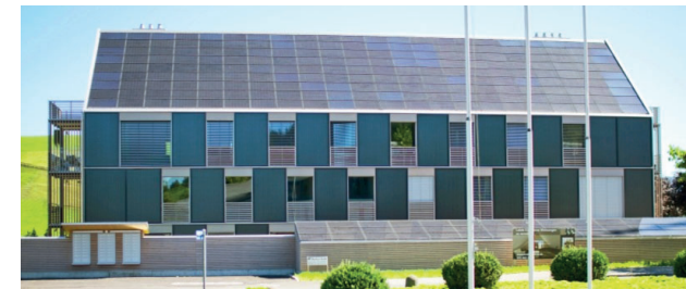
Imagen 2.38: Fachada frontal de la edificación Fuente: Reina, 2014.
