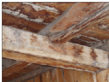
viga-solera inferior de eucalipto (14X16cm)
