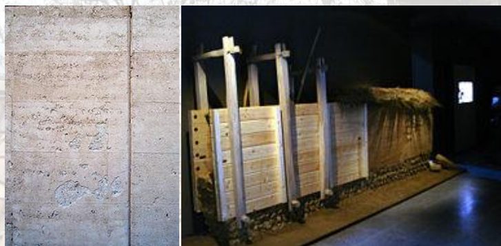
Detalle de muro de tapia Modo de ejecución del tapial
