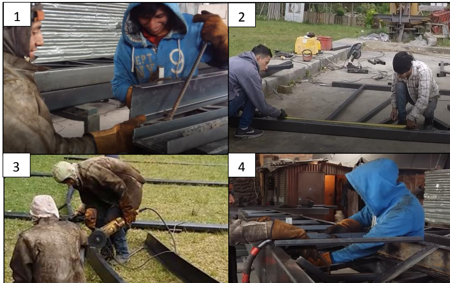
Fotografía 1. Actividades del armador: 1. Enderezado, 2. Trazado, 3. Cortado, 4. Fijado Elaboración: Autor.
