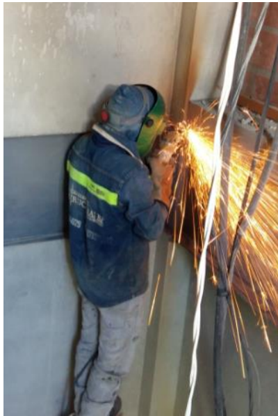
Fotografía 28 Soldador – Limpieza de superficie para evitar porosidad en la soldadura.
