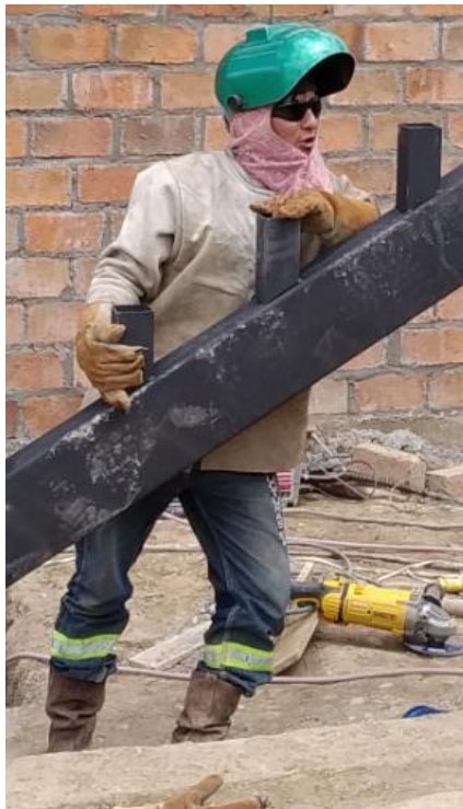
Fotografía 19 Armador – Enderezado en obra de tiro para grada.
