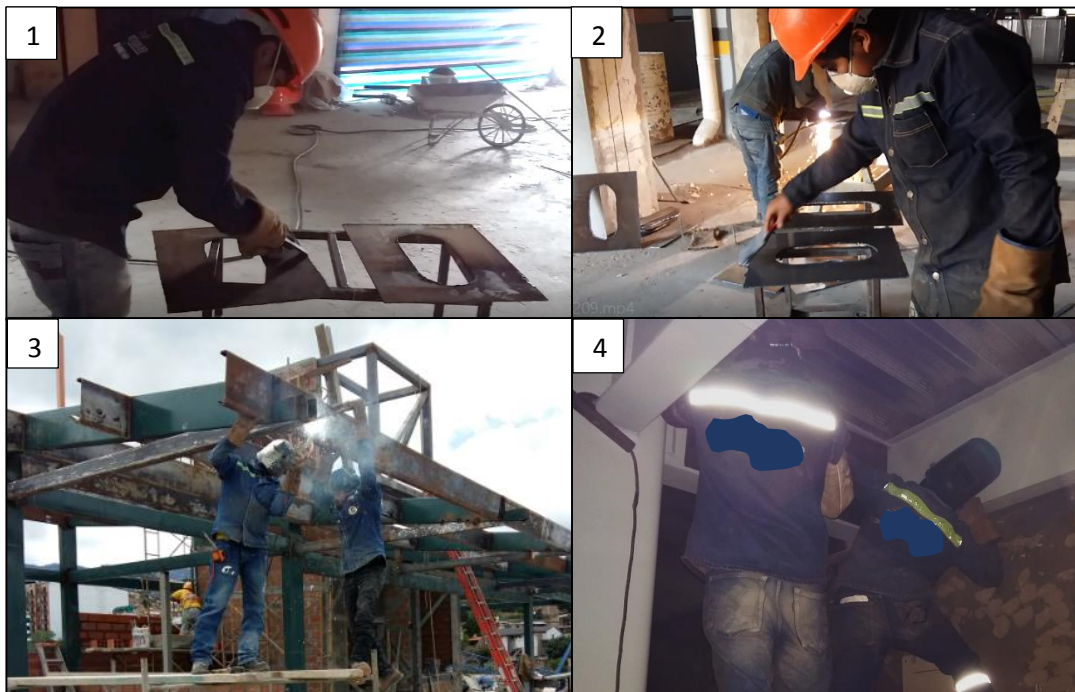
Fotografía 6. Ayudante en obra: 1. Limpieza de material para refuerzo 2. Pintura básica donde no se necesite acabado superficial, 3. Soporte para ensamble de estructura 4. Soporte para colocación de refuerzos.
