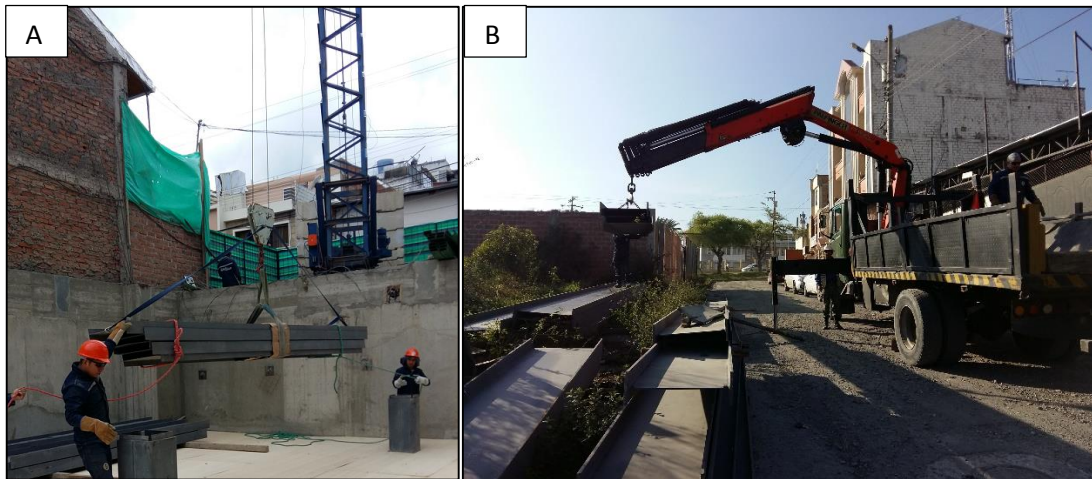
Figura 29 A) movilización de cargas mediante torre automontante. B) movilización de carga camión grúa
