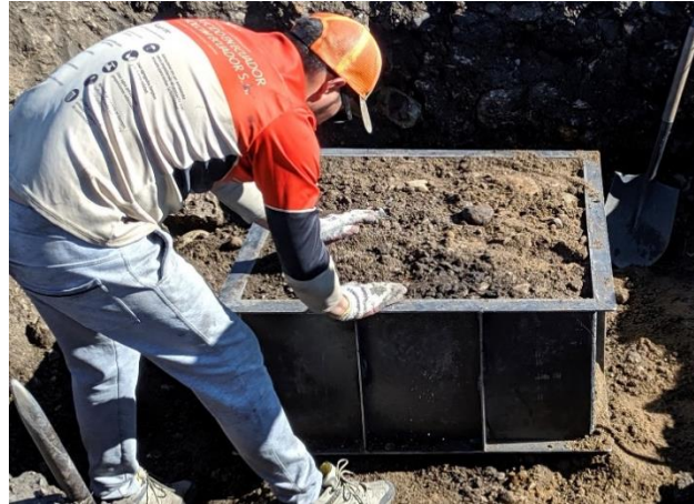
Figura 36. Rellenado de espacios vacíos.
