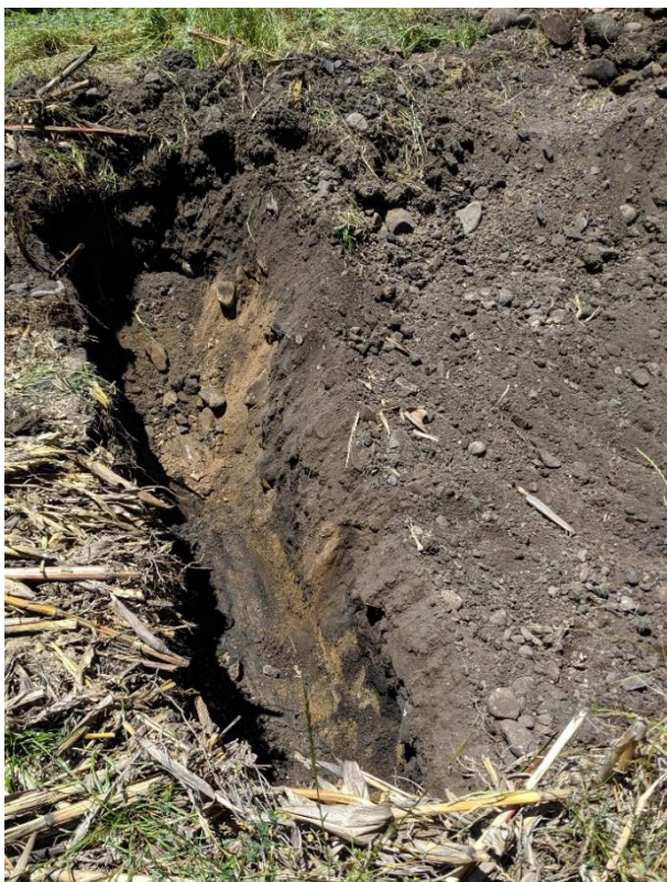
Figura 32. Excavación de zanjas en bordes de calicata.
