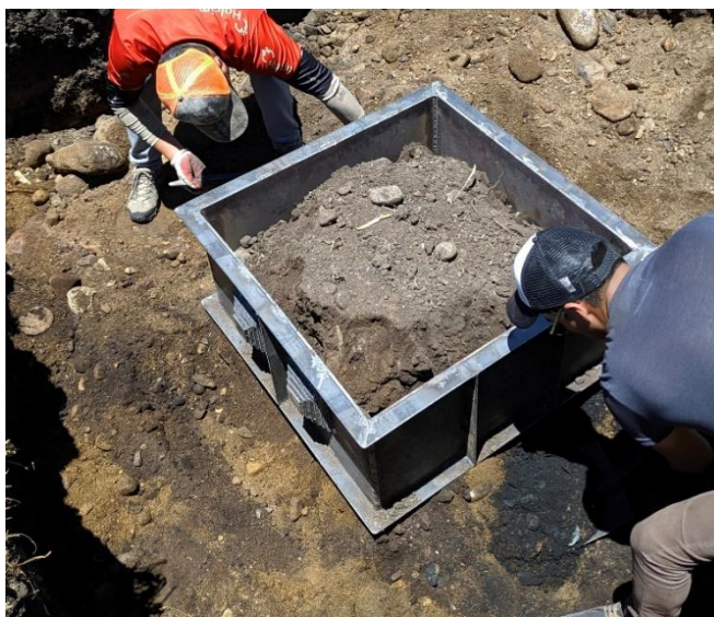
Figura 35. Excavación manual de suelo.
