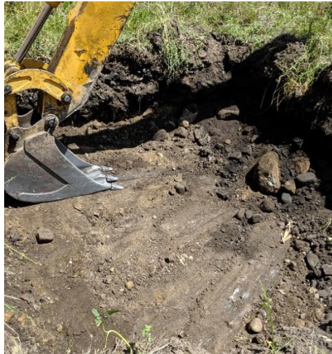
Figura 31. Excavación de calicata.
