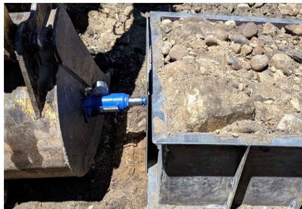
Figura 37. Colocación de gato hidráulico.
