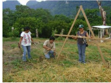
Imagen 4. Ubicación de las estacas en los puntos del trazado.
