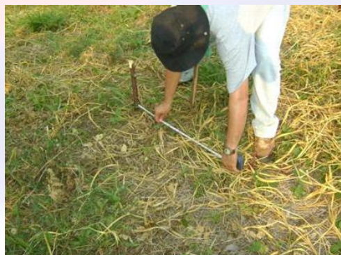
Imagen 6. Trazado de las zanjas de acuerdo a la curva de nivel
