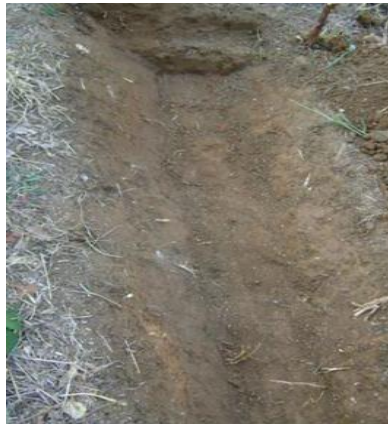
Imagen 8. Zanja de infiltración establecida.
