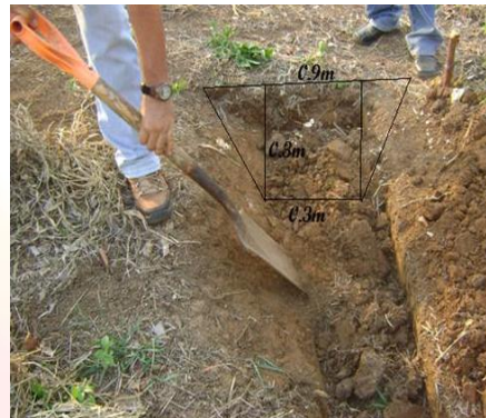
Imagen 7. Excavación de la zanja.
