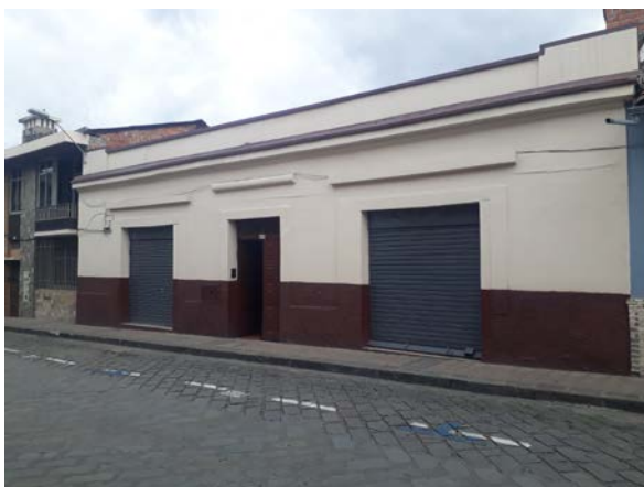
Ilustración No. 2.30: calle Mariscal Sucre. Cambio de materialidad de accesos y eliminación de aleros.
