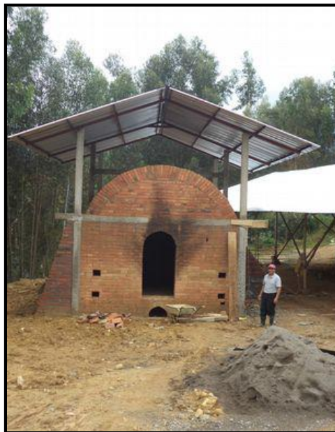
Figura 3 Horno de tiro invertido (Belli, 2015).
