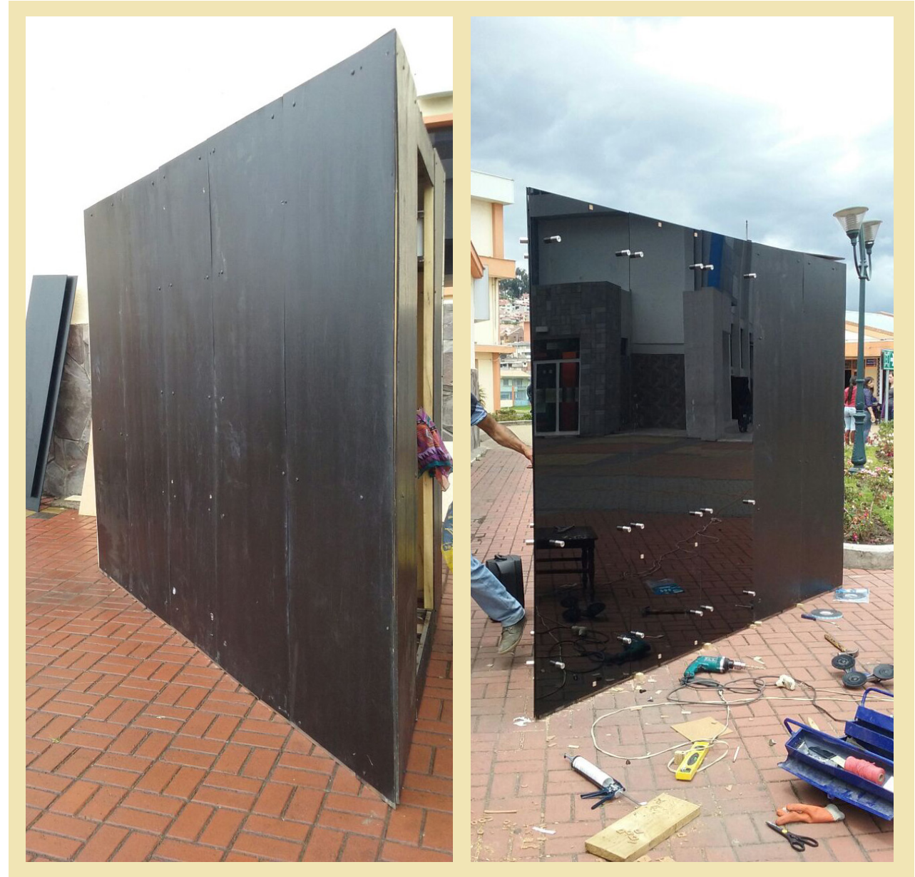
FIGURA 49 Molina, N. (2016) INSTALACIÓN DE VIDRIO SOBRE MADERA EN LA FACHADA EXTERIOR
