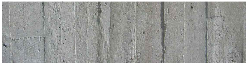
MATERIALIDAD HORMIGÓN VISTO - ENCOFRADO DE DUELA DE MADERA
