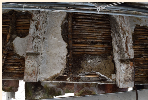
Fig. 52: Vivienda vernácula primigenia 0102053002, cielo raso con pares expuestos. Elaboración: Propia
