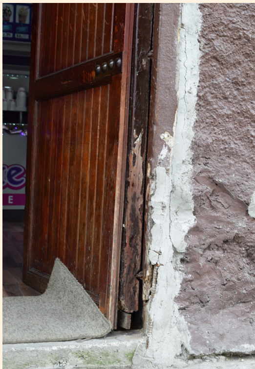
Fig. 64: Vivienda vernácula simple 0102041045, jamba. Elaboración: Propia
