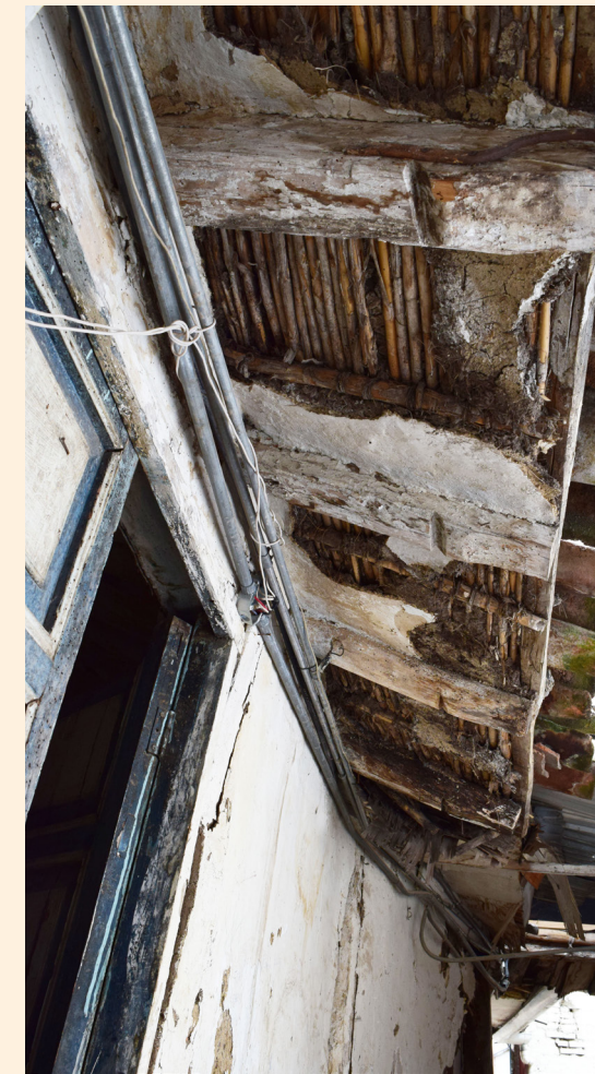
Fig. 19: Vivienda vernácula primigenia, pares expuestos. Elaboración: Propia
