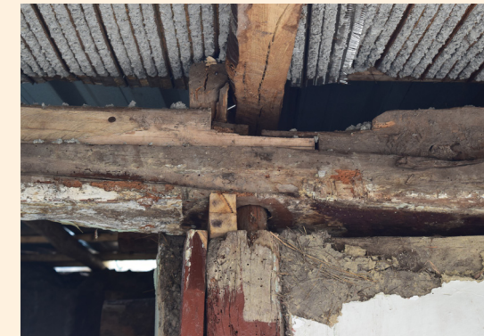
Fig. 81: Vivienda vernácula aportada 0102033024, empalme con caja y espiga (viga-columna) y ensamble a media madera (viga-viga). Elaboración: Propia.
