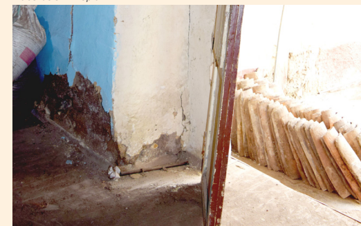
Fig. 78: Vivienda vernácula aportalada 0102033024, piso de duela con cámara de aire. Elaboración: Propia.
