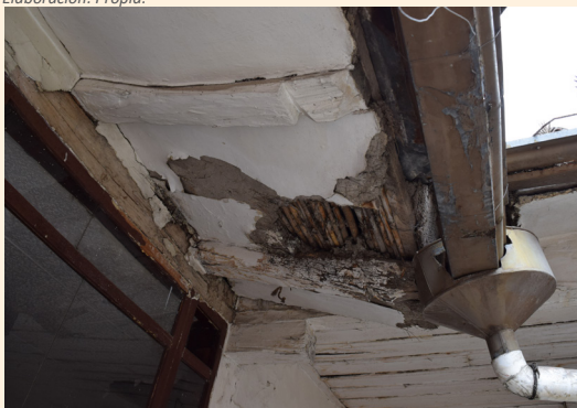
Fig. 86: Vivienda vernácula aportalada 0102033024, cielo raso con pares vistos. Elaboración: Propia.
