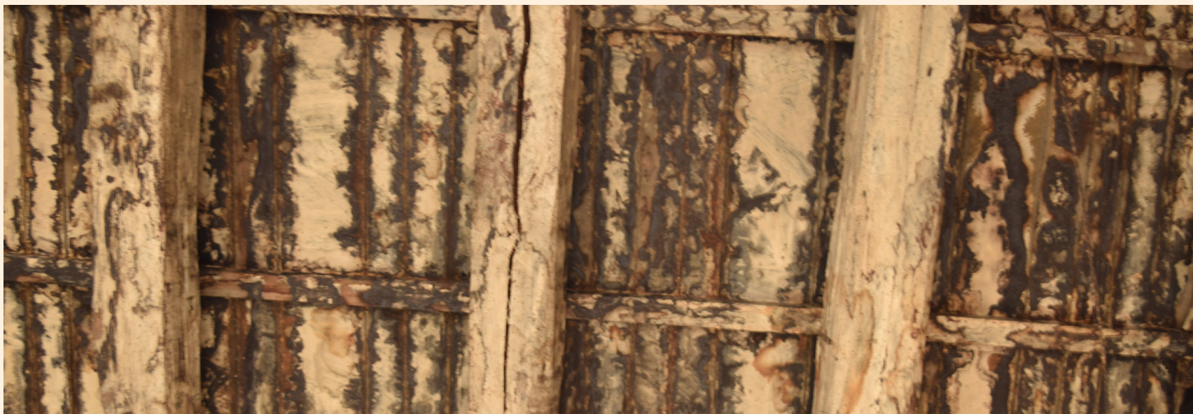
Fig. 18: Calle las herrerías, piso de madera. Elaboración: Propia
