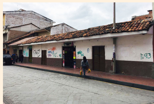
Fig.36: Fachada Norte, vivienda vernácula primigenia 0102053002 . Elaboración: Propia
