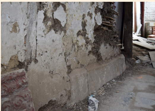
Fig. 45: Vivienda vernácula primigenia 0102053002, sobrecimiento. Elaboración: Propia
