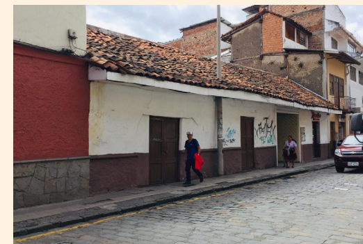
Fig.37: Fachada Oeste, vivienda vernácula primigenia 0102053002. Elaboración: Propia
