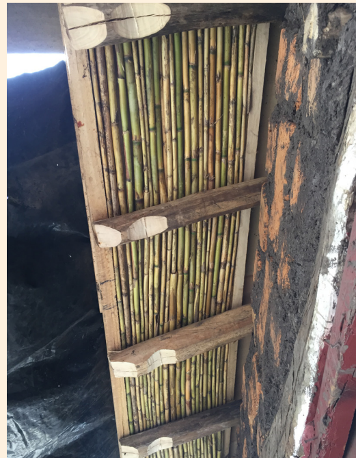
Fig. 22: Vivienda vernácula simple, destaje en pares vistos, calle las Herrerías. Elaboración: Propia.
