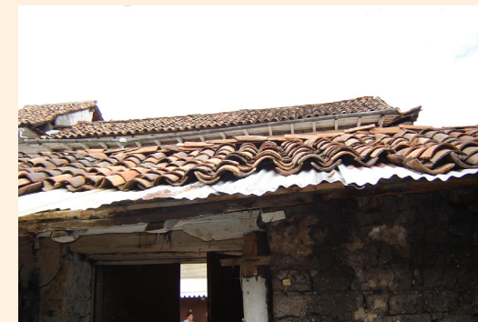
Fig. 55: Vivienda vernácula primigenia 0102053002, intervenciones en la cubierta. Elaboración: Propia
