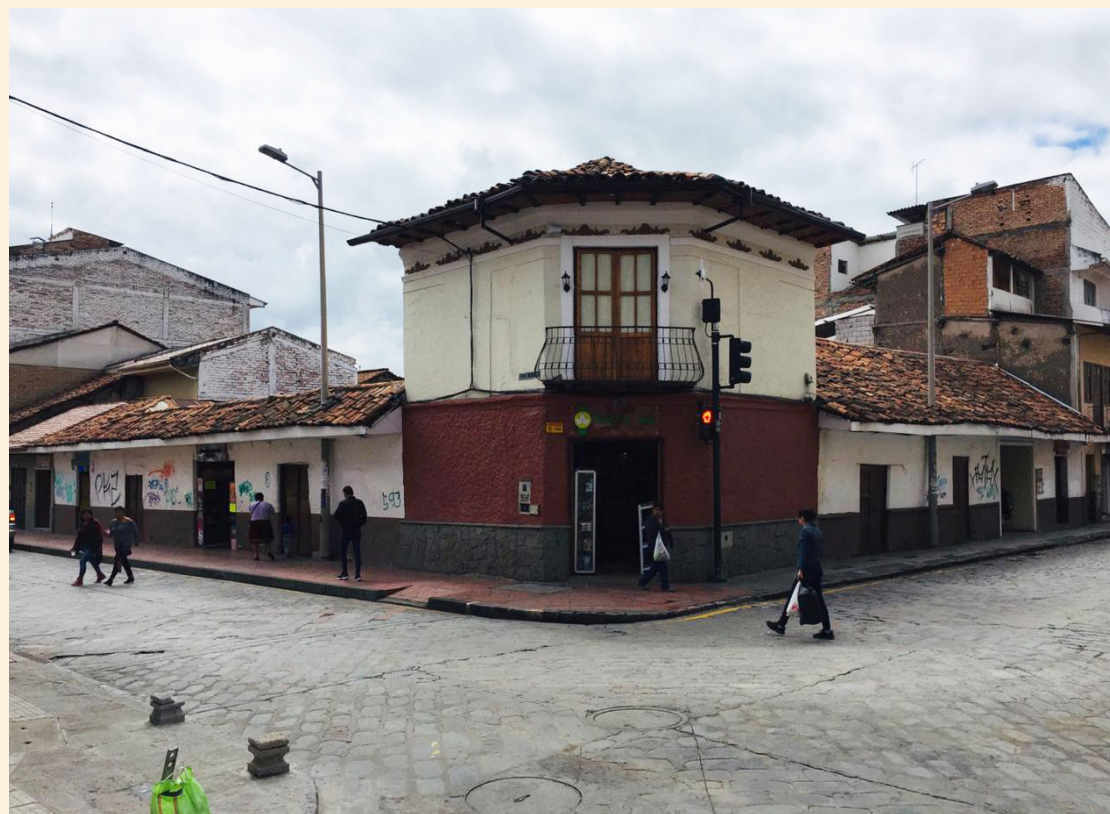
Fig.38: Esquina, vivienda vernácula primigenia 0102053002. Elaboración: Propia
