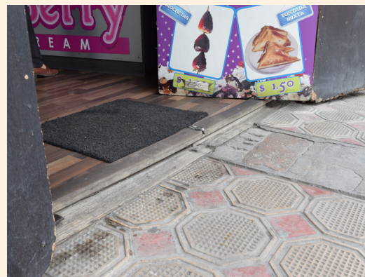
Fig. 62: Vivienda vernácula simple 0102041045, solera de cimentación interrumpida, pieza clavada por debajo del piso terminado. Elaboración: Propia
