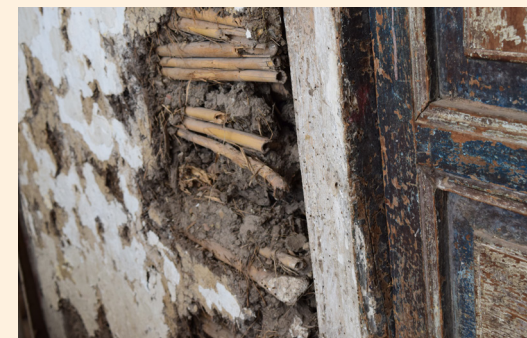
Fig. 49: Vivienda vernácula primigenia 0102053002, muro de bahareque/enchaleado. Elaboración: Propia
