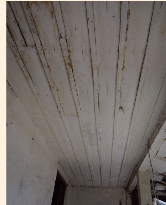
Fig. 23: Vivienda vernácula simple, cielo raso, junta y tapa junta. Elaboración: Propia.
