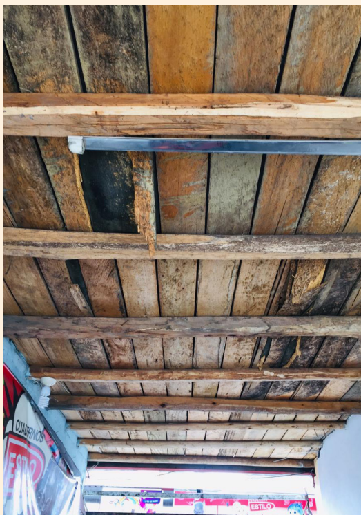
Fig. 51: Vivienda vernácula primigenia 0102053002, cielo raso con vigas expuestas. Elaboración: Propia
