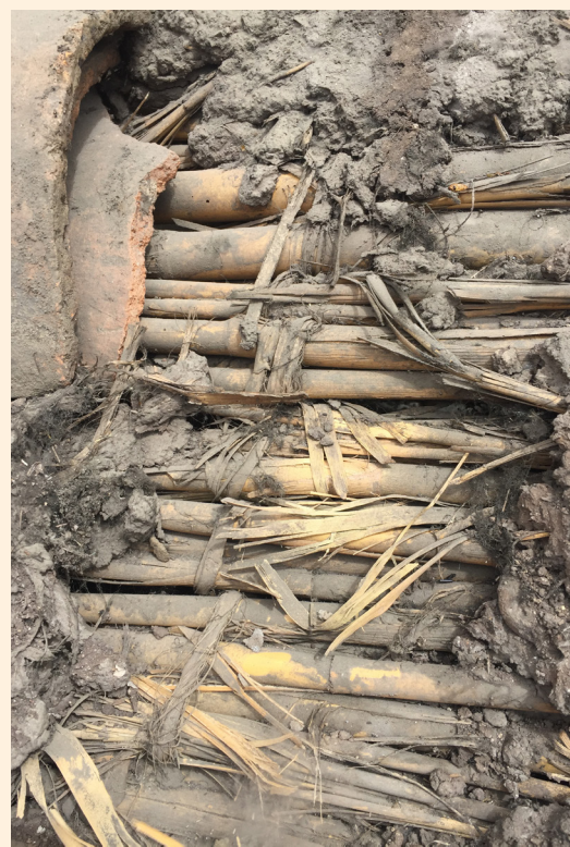
Fig. 88: Vivienda vernácula aportalada 0102033024, armadura auxiliar de cubierta. Elaboración: Propia.
