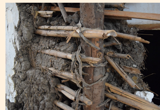
Fig. 50: Vivienda vernácula primigenia 0102053002, muro de bahareque/enchaleado. Elaboración: Propia
