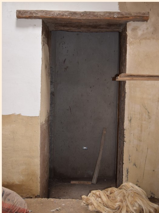
Fig. 82: Vivienda vernácula aportalada 0102033024, muro de adob, revoque y empañete. Elaboración: Propia.
