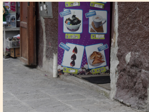
Fig. 63: Vivienda vernácula simple 0102041045, solera de cimentación continua formando grada en el ingreso. Elaboración: Propia
