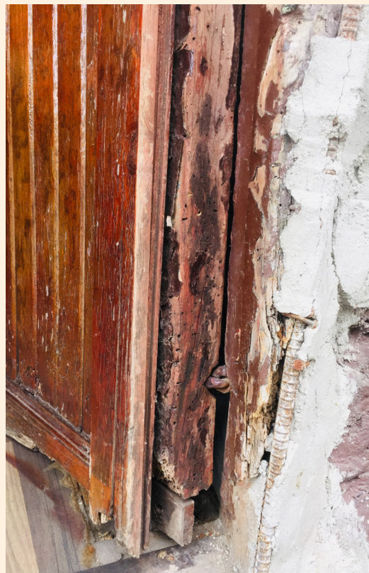
Fig. 57: Vivienda vernácula simple 0102041045, puerta original recubierta. Elaboración: Propia
