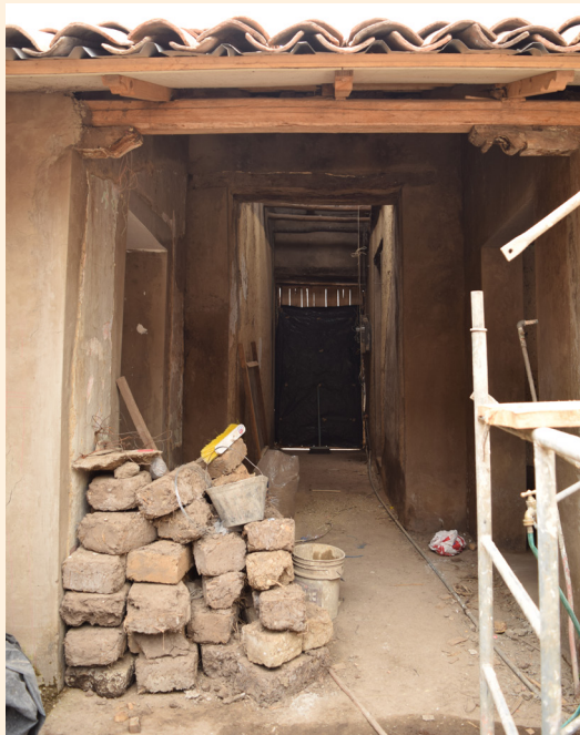
Fig. 79: Vivienda vernácula aportada 0102033024, solera de cubierta. Elaboración: Propia.
