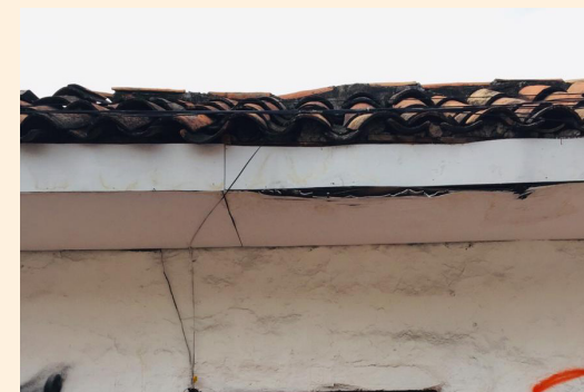
Fig. 54: Vivienda vernácula primigenia 0102053002, cubierta sin canal. Elaboración: Propia
