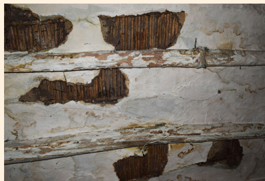
Fig. 53: Vivienda vernácula primigenia 01025302, armadura auxiliar de cubierta. Elaboración: Propia
