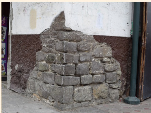
Fig. 61: Vivienda vernácula simple 0102041045, vestigio de almohadillado de piedra de cantera inca. Elaboración: Propia
