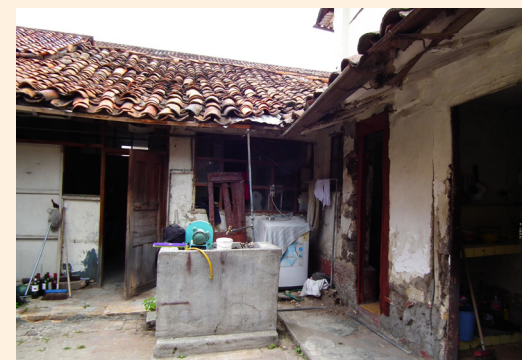
Fig. 73: Anónimo. Patio central y crujía frontal, vivienda vernácula aportalada 0102033024. Fuente: Sistema de documentación de las áreas históricas y patrimoniales.
