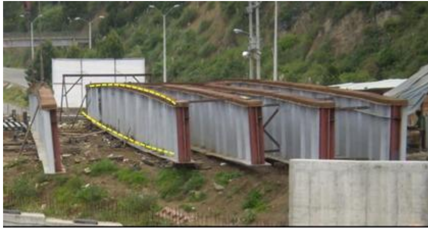
Ilustración 2.4. Vigas metálicas con su respectiva contraflecha, antes de su colocación. Fuente: Campoverde, 2017.
