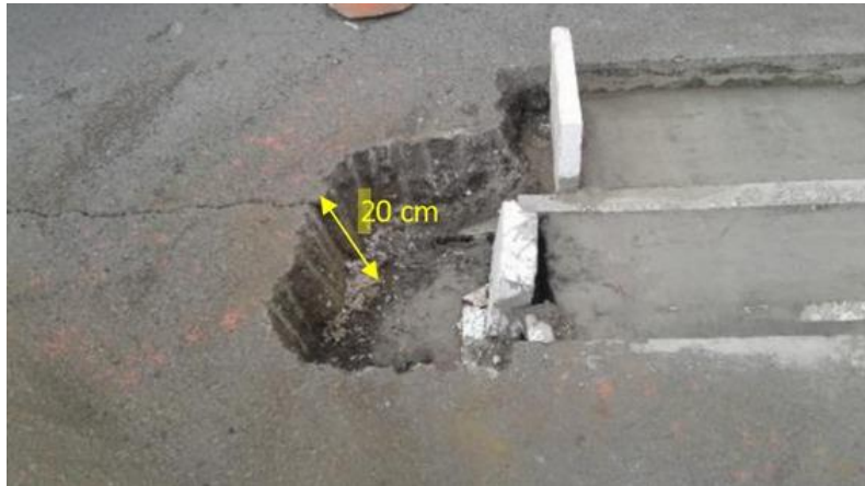
Ilustración 3.13. Capa de asfalto máxima debida al recapeo. Fuente. Campoverde, 2017.
