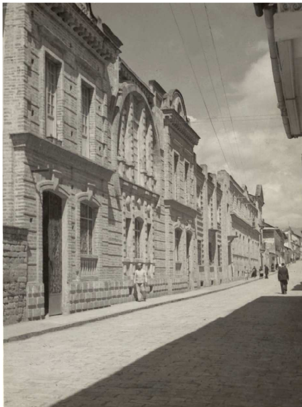
Calle Larga donde esta emplazada la Casa de Remigio Crespo Toral en un contexto de varias edificaciones de ladrillo visto. Archivo Fotográfico Dr. Miguel Díaz Cueva
