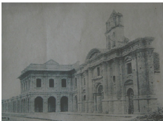
La Iglesia de San Francisco en construcción, 1921. Archivo Fotográfico Dr. Miguel Díaz Cueva
