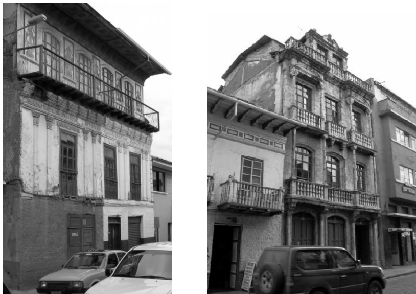
Fachada 1 de 1907 y fachada 2 de 1928 de la Casa de la Bienal cuyo primer propietario fue José Antonio Alvarado. Foto: J. Tómmerbakk
