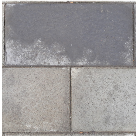
FIG. 217: Trama adoquín de 30x60x8cm.
