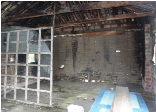
Ilustración 373: Segunda planta alta, muro de bahareque. Punto de información y registro. Fuente: Proyecto CPM, 2017
