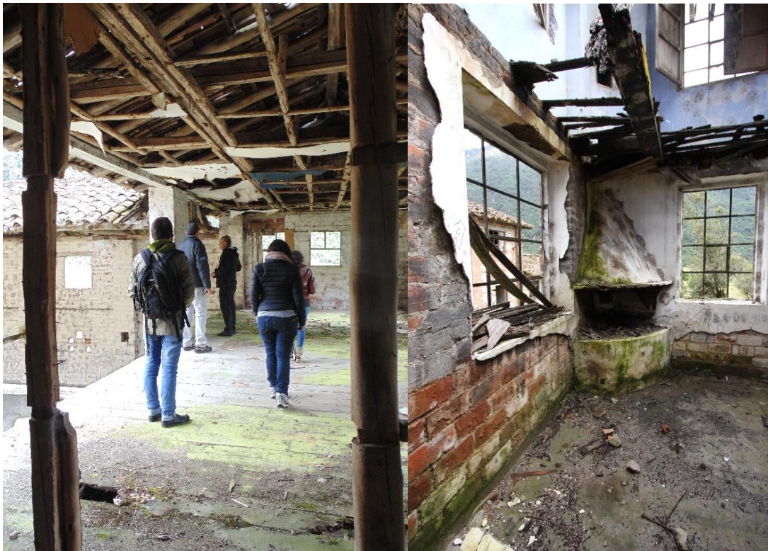
Ilustración 331: Inspecciones del lugar - sistemas constructivos en ladrillo y madera Fuente: Proyecto vlir CPM, 2016
