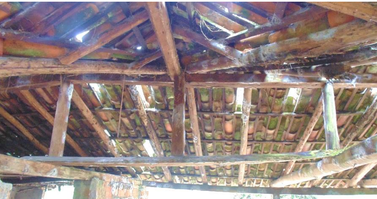
Ilustración 323: Sistema tradicional de madera a recuperar – bloque A Fuente: Proyecto CPM, 2017
