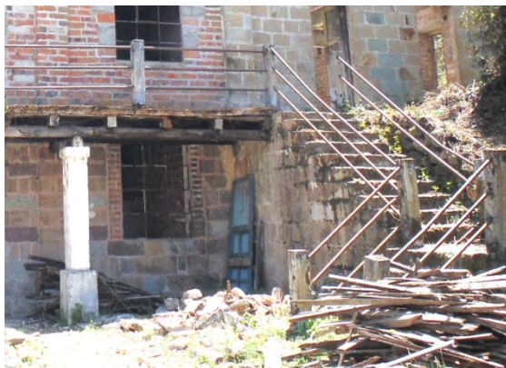
Ilustración 335: Pasamanos oxidados, en la fachada oeste de la edificación. Fuente: Proyecto CPM, 2018
