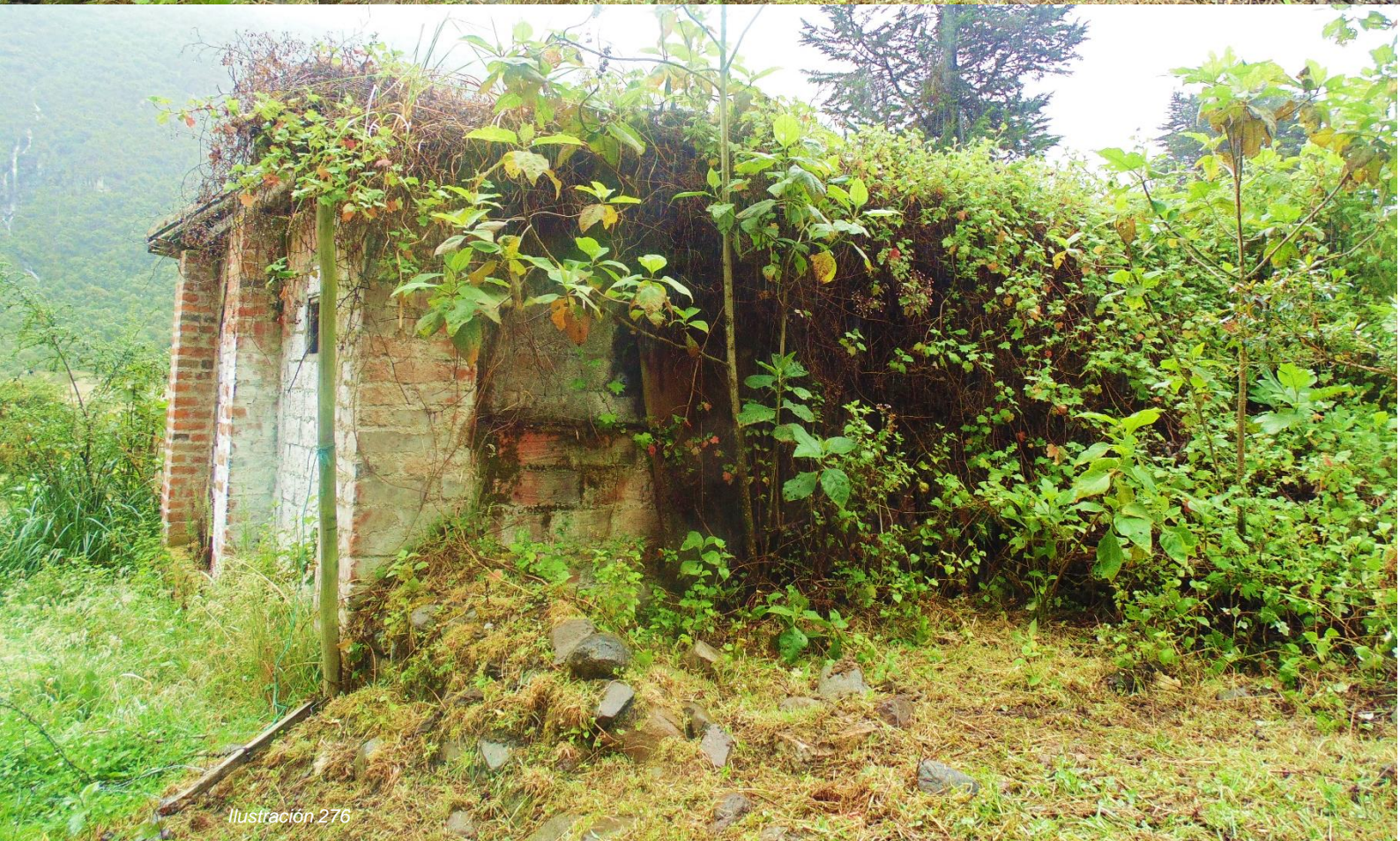
Ilustraciones 275, 276: Crecimiento de vegetación y acumulación de barro en interior y exterior de la hacienda. Fuente: Proyecto vliir CPM, 2016
