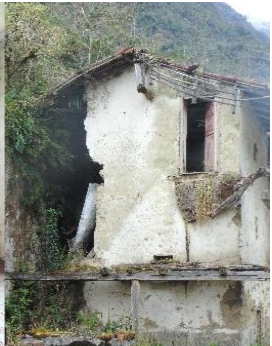
Ilustración 264: Construcción en adobe. Fuente: Rodas et al. (2017)
