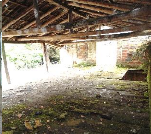
Ilustración 262: pudrición de entrepiso Fuente: Rodas et al. (2017)
