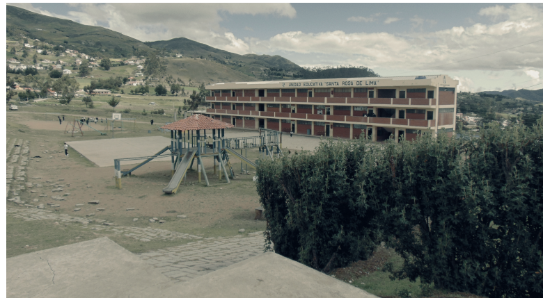
Fig 147: Bloque de aulas, nueva escuela Santa Rosa de Lima /2018
