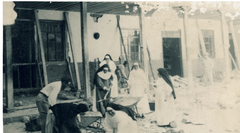
Fig 144: Monjas trabajando en la refacción de la edificación
