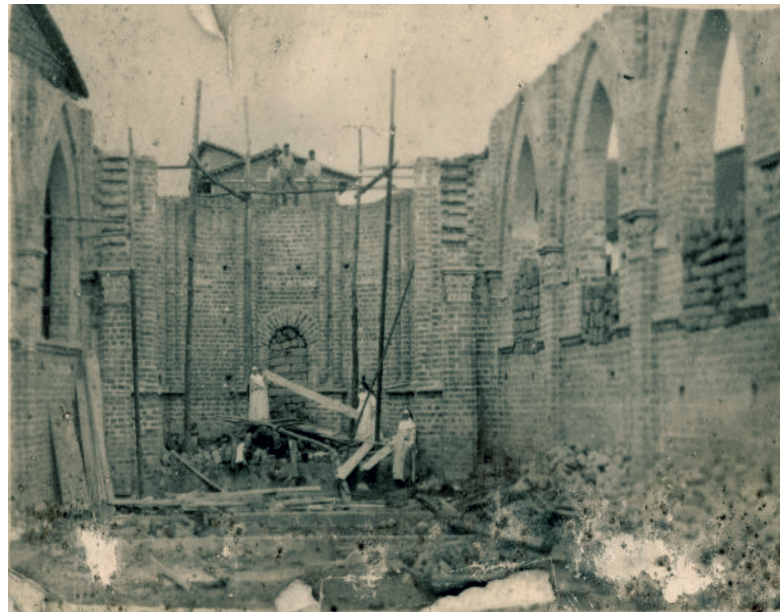
Fig 139: Construcción de la Capilla Santa rosa de Lima
