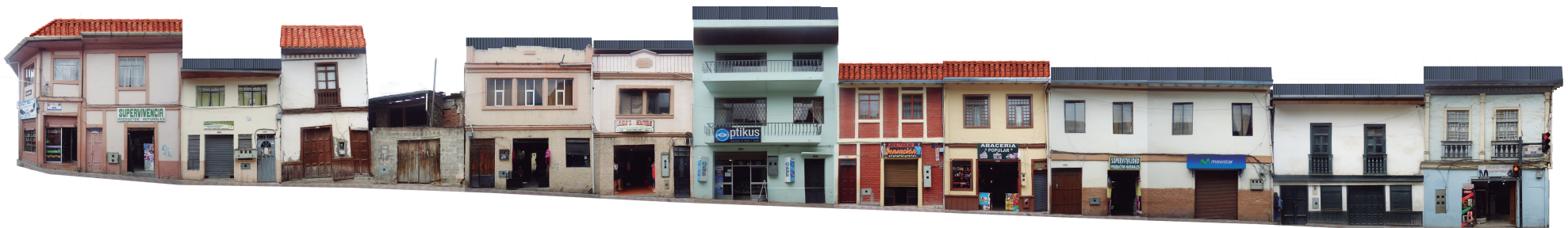
Fig 133: Tramo rectificado. Calle Bolívar
