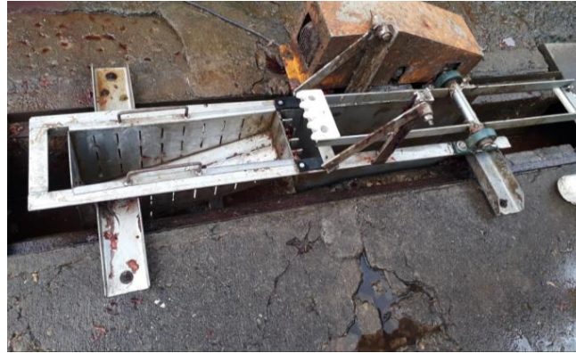
Ilustración 51 Rejillas Agua Residual EMURPLAG EP
