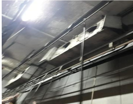
Ilustración 41 Ventilador Cuarto Frío
