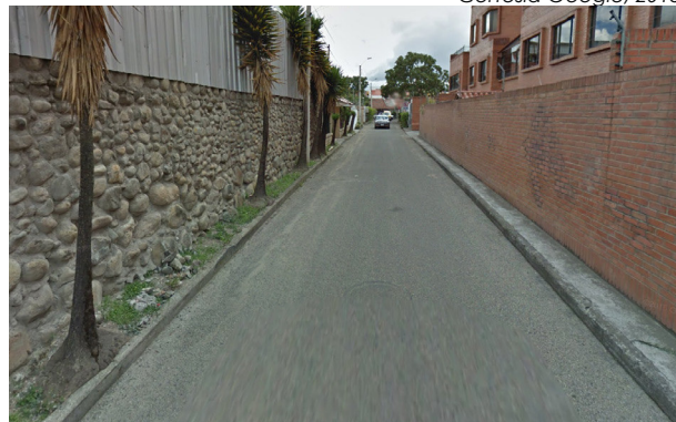
Fig 140. Calzada de pavimento. Cortesía Google, 2015.
