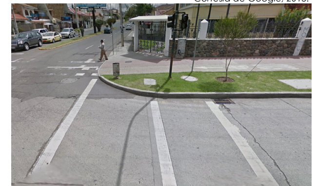
Fig 30. No existe rampa. Cortesía de Google, 2015.
