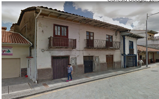
Fig 78. Edificación estado malo. Cortesía Google, 2015.
