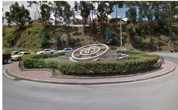
Fig 159. Mantenimiento general bueno. Cortesía Google, 2015.
