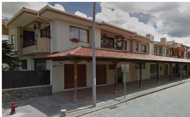
Fig 76. Edificación estado bueno. Cortesía Google, 2015.
