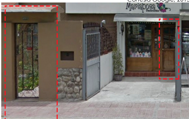
Fig 70. Puertas peatonales en edificación Cortesía Google, 2015.
