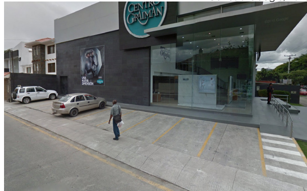
Fig 87. Sin cerramiento. Cortesía Google, 2015.
