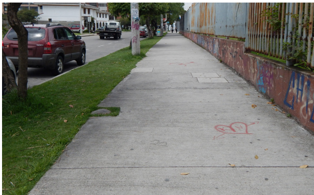
Fig 99. Acera de concreto. Autores, 2018.
