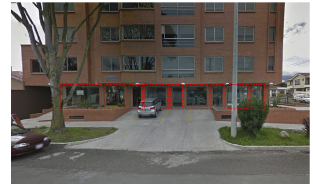
Fig 75. Ventanas en edificación sin cerramiento. Cortesía Google, 2015
