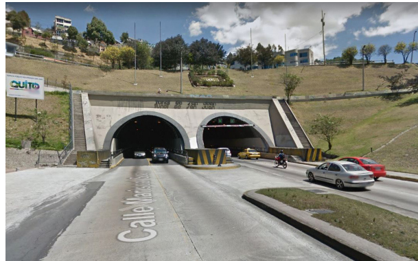
Fig 7. Segmento túnel. Cortesía Google, 2015.
