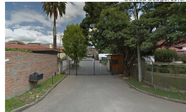
Fig 138. Entrada o callejón vehicular. Cortesía Google, 2015.
