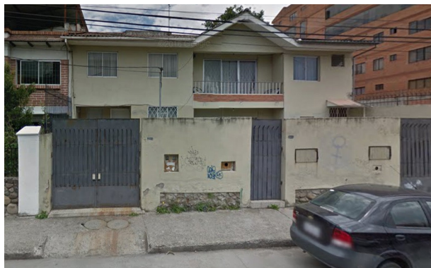
Fig 77. Edificación estado regular. Cortesía Google, 2015.
