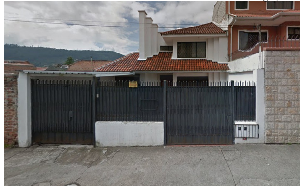
Fig 82. Cerramiento opaco. Cortesía Google, 2015.
