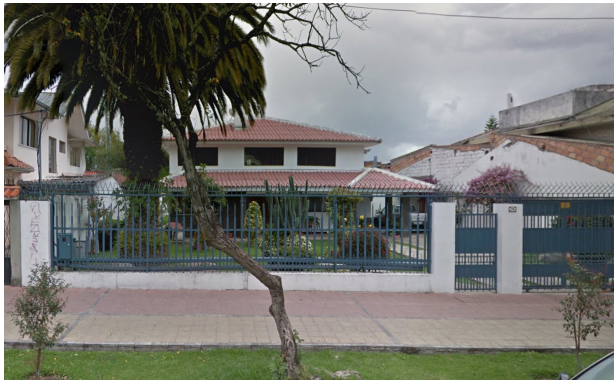
Fig 84. Cerramiento rejas. Cortesía Google, 2015.
