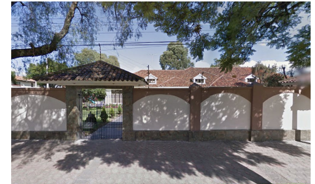
Fig 83. Cerramiento construido. Cortesía Google, 2015.
