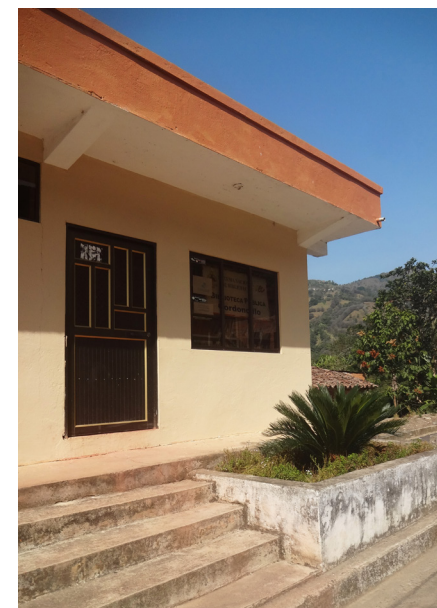
Ilustración 40: Fachada de biblioteca actual
