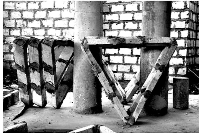
Imagen 200: Prefabricados triangulares compuestos por 9 ladrillos
