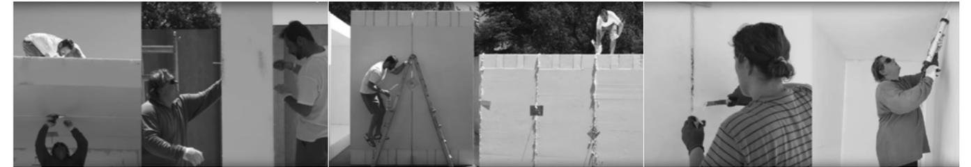
10. Retiro de grapas metálicas 11. Aplicación de engrudo 12. Limpieza de exedentes y aplicación de engrudo
