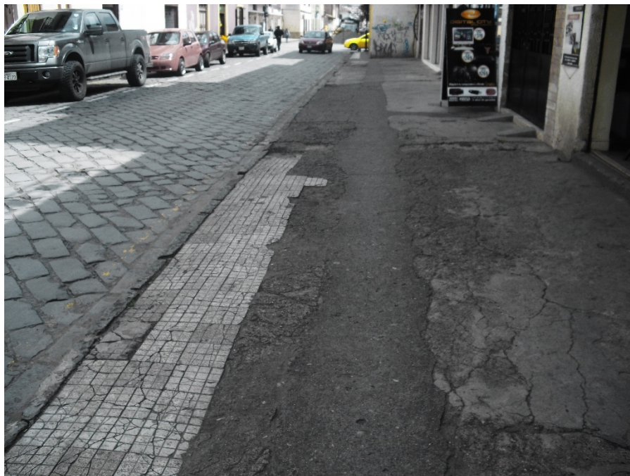
Fotografía 4.4: Tramo T 35. Deterioro de la calzada y la acera
