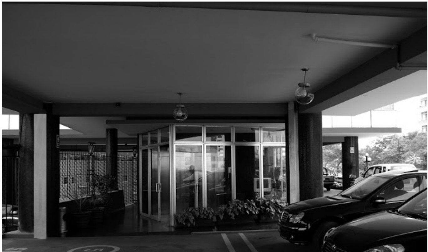
Figura 144: Ingreso por estacionamiento. Edificio El Pacífico (2013)
