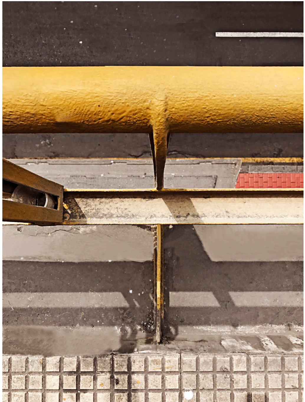
Figura 124: encuentro entre piso y baranda (2016) Fuente: muro_arquitectos (2016) Digitalización: Ortiz, J. (2016)
