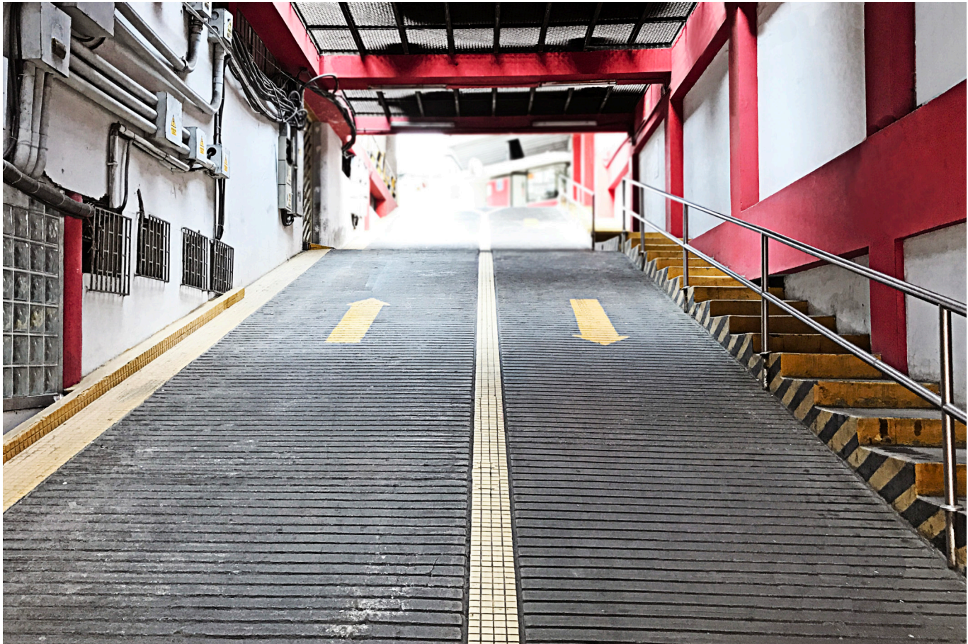
Figura 114: Rampa de ascenso a estacionamiento
