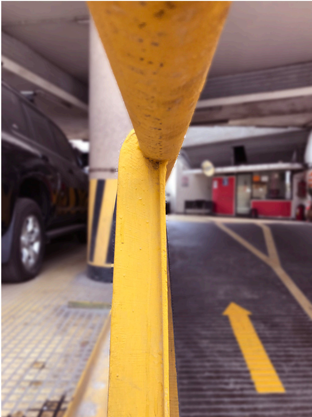
Figura 125: detalle baranda (2016) Fuente: muro_arquitectos (2016) Digitalización: Ortiz, J. (2016)
