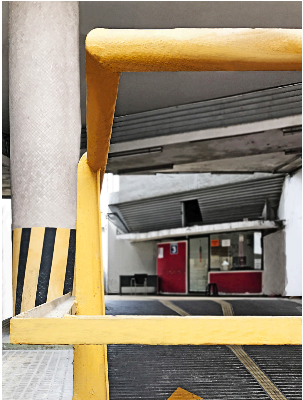
Figura 126: detalle baranda (2016) Fuente: muro_arquitectos (2016) Digitalización: Ortiz, J. (2016)
