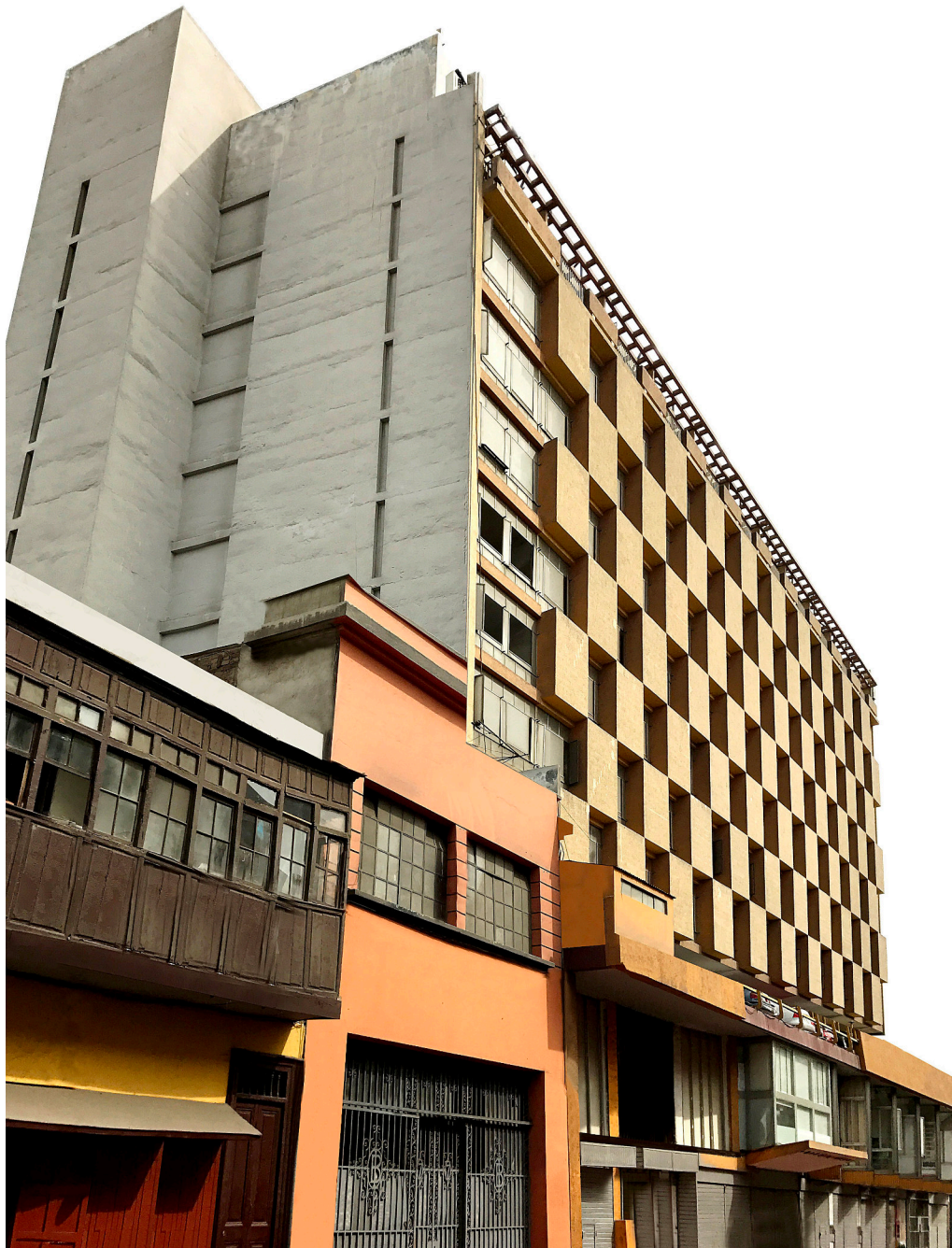
Figura 106: jr. Cailloma. Edificio Hotel Savoy (2016) Fuente: muro_arquitectos(2016) Digitalización: Torres, C. (2016)
