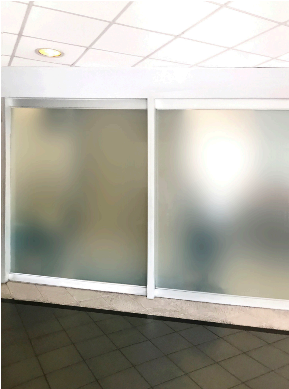
Figura 162: Cerramiento pavonado.2016) Fuente: Muro_arquitectos (2016) Digitalización: Davila, A. (2016)
