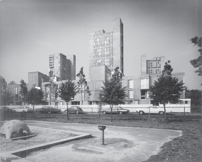
Fig. 55. Vista del conjunto completo del [PT] desde el este detrás de Putnam Ave. (1965).
