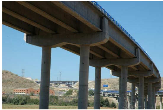
Figura 11. Ejemplo de puente tipo viga. Puente vehicular con estructura portante constituida por vigas de hormigón armado
