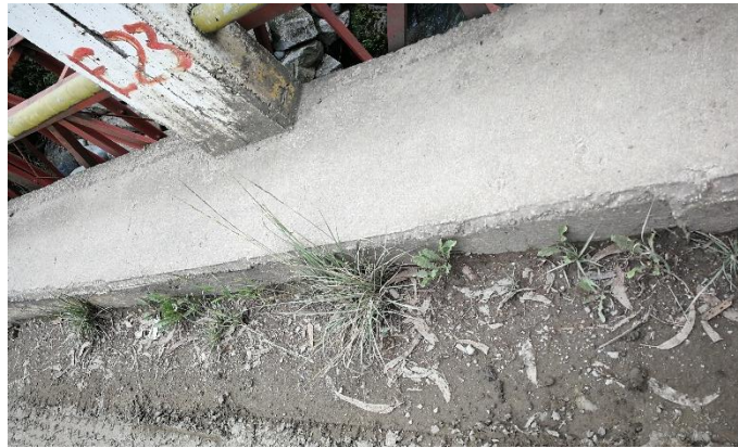
Figura 63. Muestra de la acumulación de lodo en el extremo de la calzada del puente Ochoa León.
