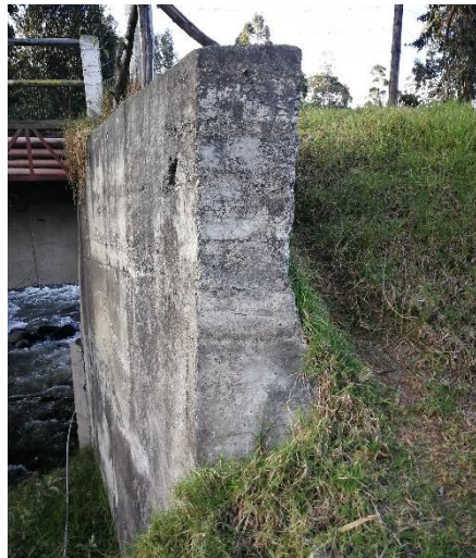
Figura 41. Ala derecha del puente Ochoa León, presencia de desgaste de hormigón.
