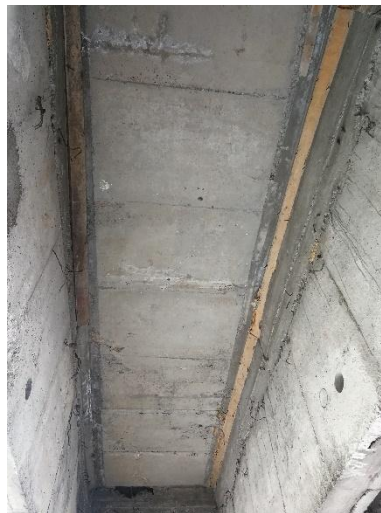
Figura 51. Presencia de eflorescencias en la cara inferior de la losa del puente Ochoa León.
