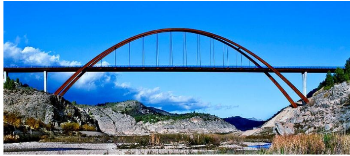
Figura 12. Ejemplo de puente en arco. Puente vehicular con estructura portante en arco de acero, donde el tablero se encuentra en la parte intermedia del arco.
