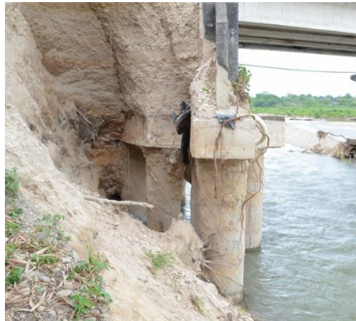
Figura 30. Estribo afectado por una socavación grave.
