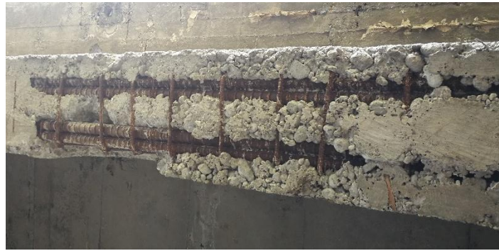
Figura 53. Oxidación de los aceros de refuerzo de las vigas del puente Ochoa León.
