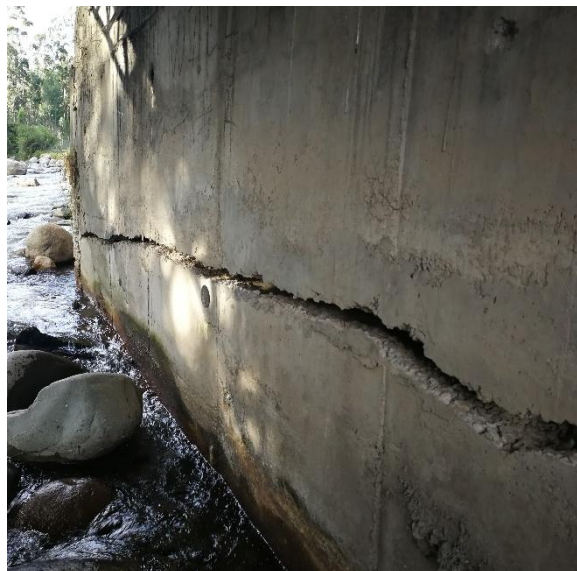
Figura 44. Grieta horizontal en el estribo derecho del puente Ochoa León.
