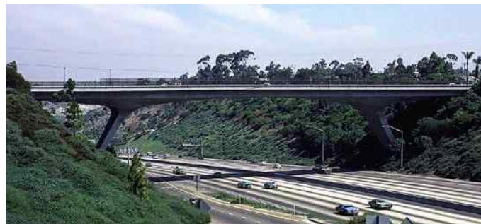
Figura 15. Ejemplo de puente tipo pórtico. Puente vehicular con estructura portante tipo pórtico.
