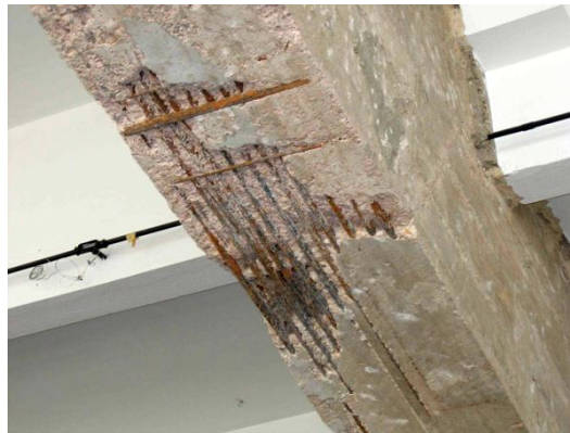
Figura 26. Barras de acero de refuerzo de una viga expuestas por falta de recubrimiento.
