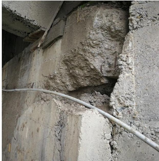
Figura 46. Desprendimiento de hormigón ciclópeo en el estribo derecho del puente Ochoa León.
