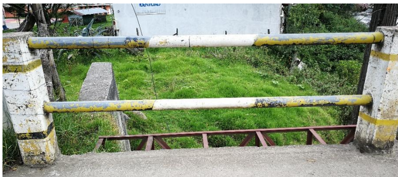
Figura 58. Tubos de acero pertenecientes a los barandales del puente Ochoa León.
