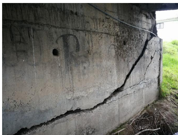
Figura 45. Grietas inclinadas en el estribo derecho del puente Ochoa León.
