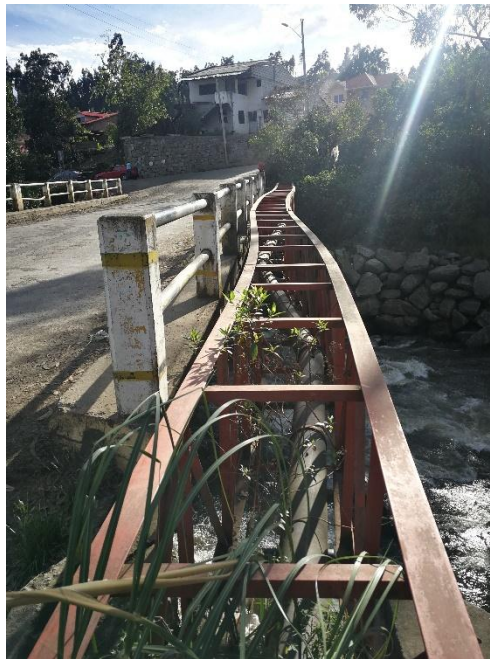
Figura 66. Estructura metálica tipo cercha, colindante con el puente Ochoa León.
