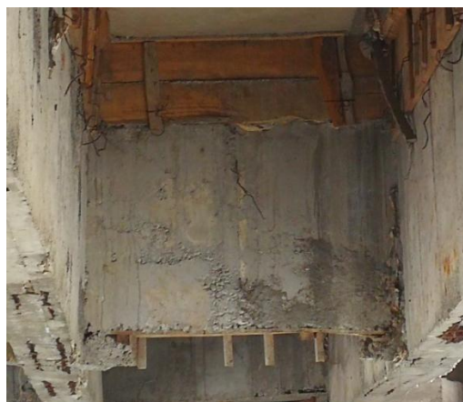
Figura 56. Cara interior del diafragma derecho del puente Ochoa León.
