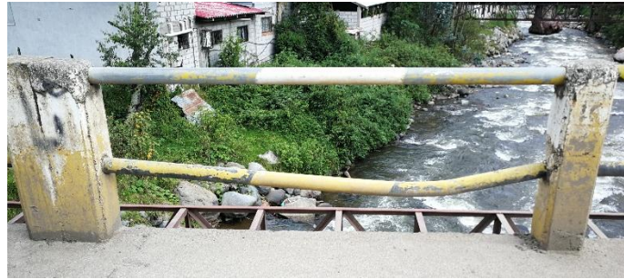
Figura 59. Tubo de acero afectado por un impacto, perteneciente a los barandales del puente Ochoa León.
