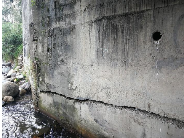
Figura 48. Contaminación de microorganismos en el estribo derecho del puente Ochoa León.
