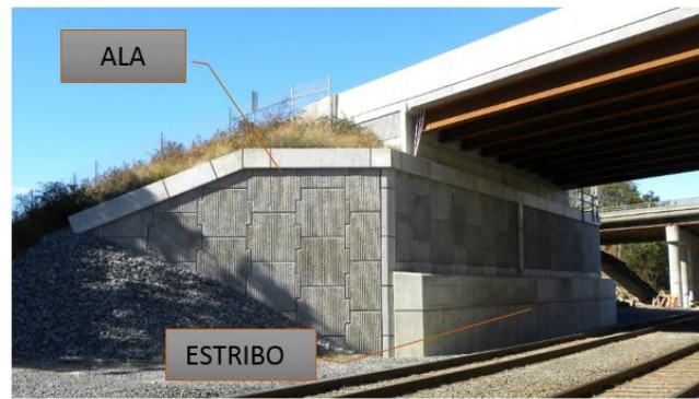
Figura 10. Estribo y ala de un puente.
