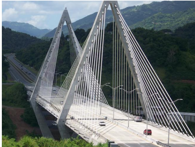
Figura 14. Ejemplo de puente atirantado. Puente vehicular con estructura portante atirantada.
