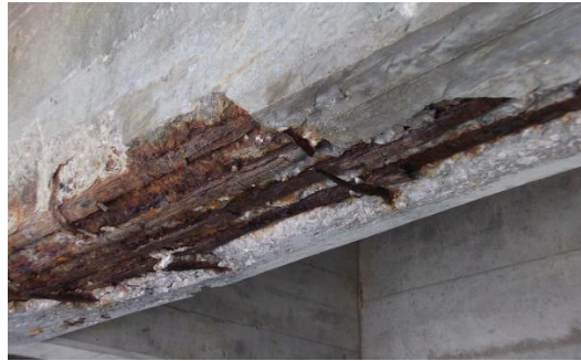
Figura 27. Oxidación de la armadura de acero de refuerzo en una viga.
