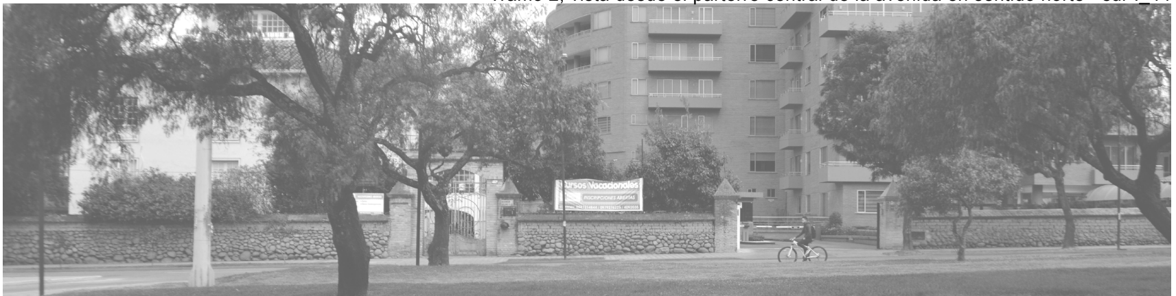
Tramo 2, vista hacia la tipología de nuevas edificaciones en el lugar I_45
