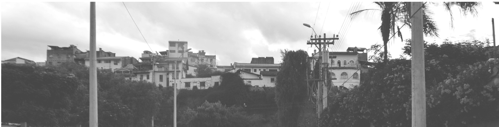
Tramo 1, vista hacia el barranco I_34
