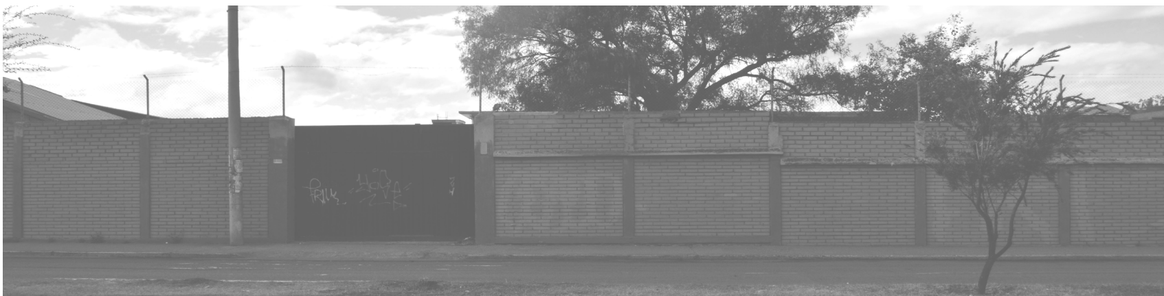
Tramo 4, vista hacia los muros de las viviendas del lugar I_55
