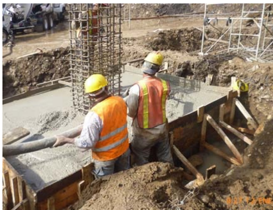
Ilustración 1. Encofrado de zapatas
