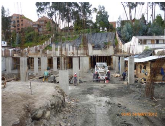
Ilustración 3. Columnas y vigas de hormigón
