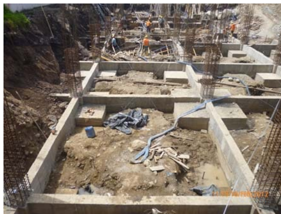
Ilustración 2. Armado de vigas de cimentación
