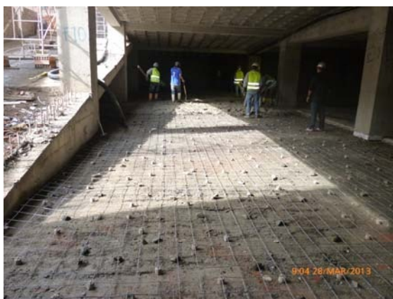
Ilustración 5. Losa de hormigón
