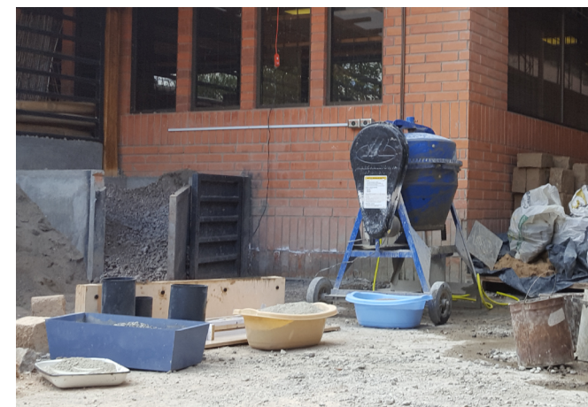
Figura 125: Lugar de fundición del hormigón con los materiales transportados al sitio. (Fuente propia)
