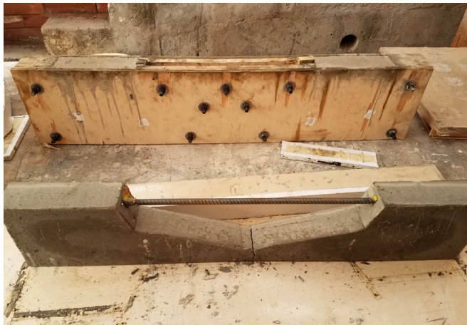
Figura 121: Encofrado de la viga tipo B. (Fuente propia)
