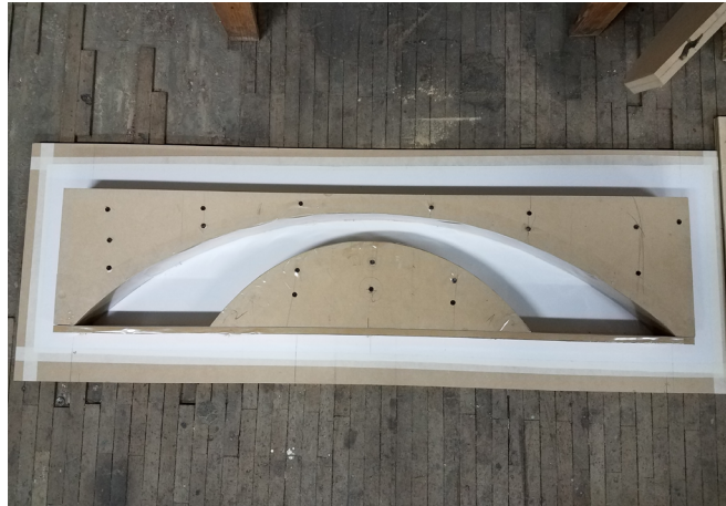
Figura 119: Encofrado de la viga tipo D. (Fuente propia)
