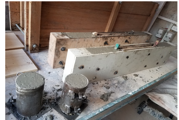
Figura 117: Encofrados de la viga tipo C. (Fuente propia)
