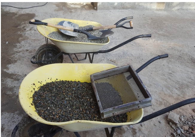
Figura 122: Lavado del agregado grueso. (Fuente propia)
