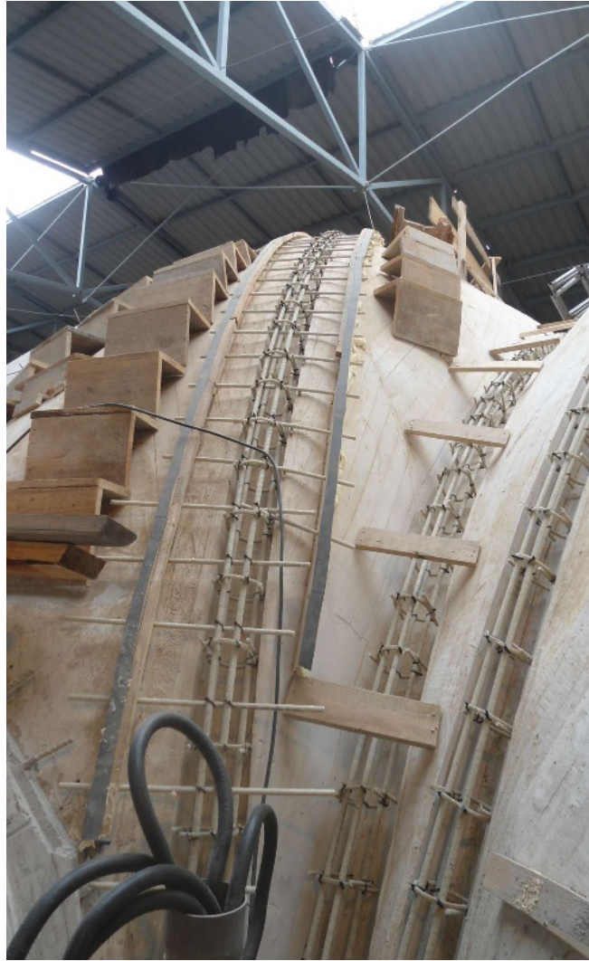
Figura 19: Reconstrucción de domos y arcos de la Catedral de la Laguna, Tenerife, Islas Canarias con GFRP Aslan 100 (Extraído de Hughes Brothers, 2017).
