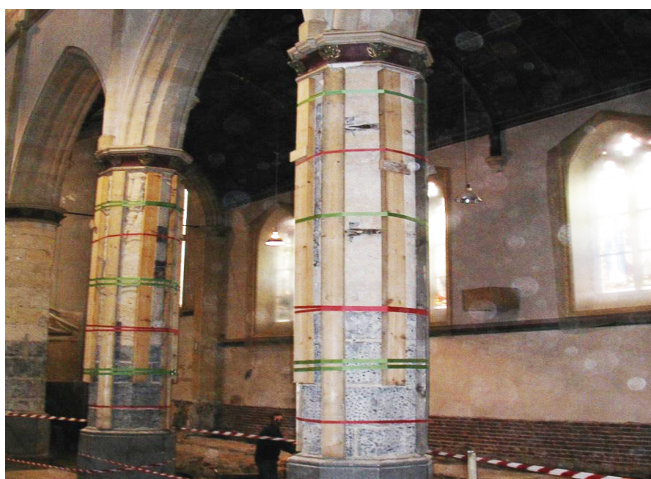
Figuras 14: Restauración de columnas implementando refuerzos de varillas de FRP (Tomada de Hughes Brothers, 2017).
