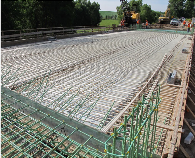
Figura 17: Armado de refuerzos de GFRP Aslan 100 del puente Elkhorn North Bridge, Washington, Nebraska (Tomada de Hughes Brothers, 2017).
