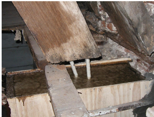
Figura 21: Ejemplo de estructuras de madera reforzadas con varillas de GFRP Aslan 100 (Tomada de Hughes Brothers, 2017).
