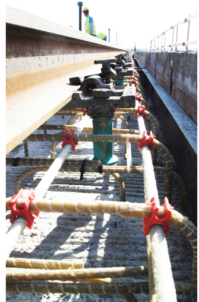
Figura 22: Rieles de tranvía con GFRP Aslan 100 (Tomada de Hughes Brothers, 2017).
