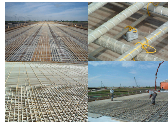
Figuras 16: Armado de refuerzos con varillas GFRP Aslan 100 del puente Floodway, Canada (Tomadas de Hughes Brothers, 2017).
