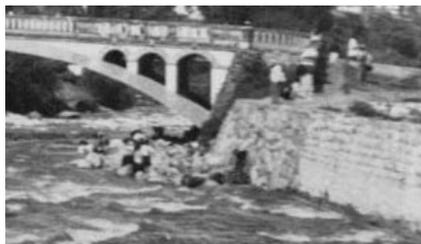
En la imagen (SA4\_05 de los años 1925-30) se observa el puente del Centenario ya concluido, ocultando el ladrillo recubierto de cal; los cimientos del antiguo puente ya no están pues probablemente desaparecieron en una de las crecidas del río Tomebamba. En las orillas del río se pueden ver a mujeres lavando ropa, actividad que se realizaba a menudo sobre en el río Tomebamba (Det. 04). En el mismo detalle se observa un muro de contención calicanto.
