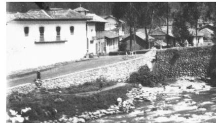
En la fotografía (AA1\_06 de 1935) se observa la primera intervención en la Av. Tres de Noviembre, a la orilla del río se construyó un muro de contención de calicanto ubicado más adentro del margen natural (Det. 06), la casa ya mencionada ubicada en la intersección de las vías ha sido recubierta con guano de caballo y en la planta baja se han cerrado puertas y ventanas.
