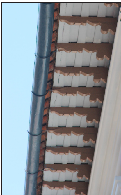
Detalle de la construcción de aleros.
