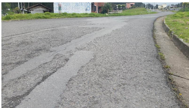
Figura 72: Áreas para ejecución de Sellado de grietas.
