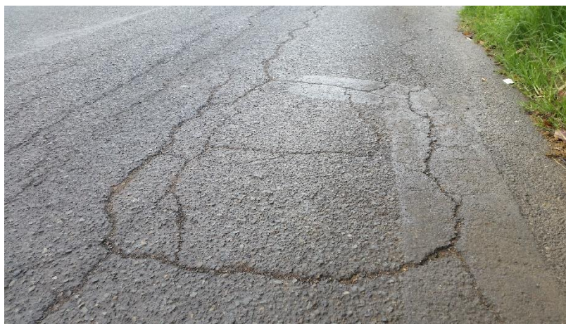
Fisuras en bloque.
