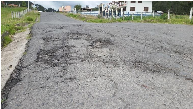
Figura 25: Falla por Hinchamiento, sector Déleg. Abs 14 +400.
