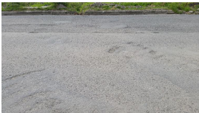
Figura 23: Falla Desplazamiento, tramo Déleg- La Raya.
