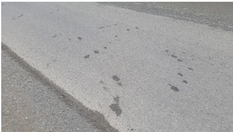
Figura 66: Áreas para ejecución de Sellos Asfáltico Tipo B1.
