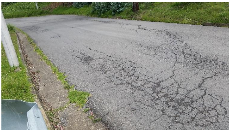
Figura 24: Falla Fisura parabólica o por Deslizamiento, sector Cojitambo.
