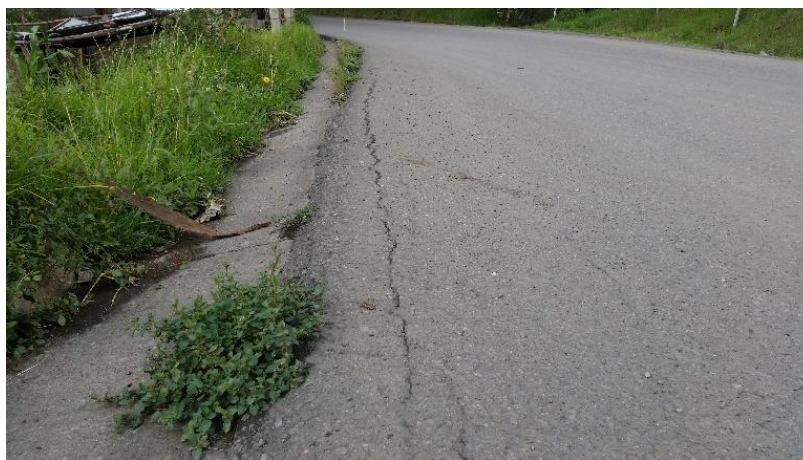
Figura 13: Falla de Borde. Abs 2 +100, tramo Azogues- Cojitambo.
