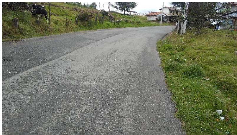
Figura 12: Falla Depresión. Abs 10 + 890, tramo Cojitambo- Déleg.
