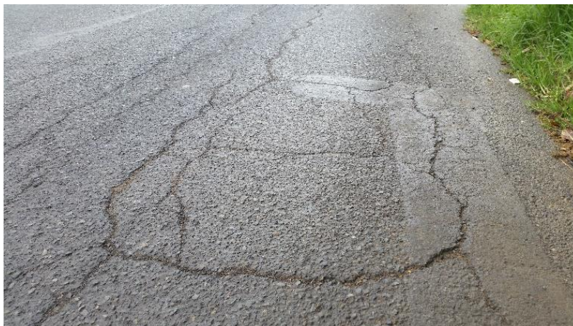
Figura 9: Falla Fisuras en bloque Abs 2+250, tramo Azogues- Cojitambo.
