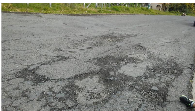
Baches- Agregado Pulido- Piel de Cocodrilo.
