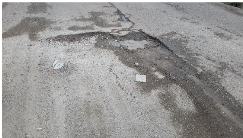
Figura 67: Áreas para ejecución de Bacheo Superficial.
