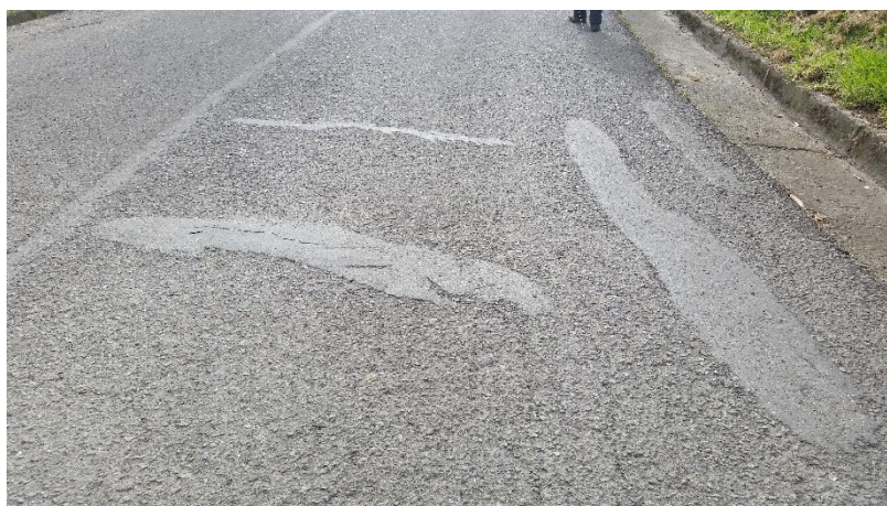
Exudación- Fisuras Longitudinales y Transversales.
