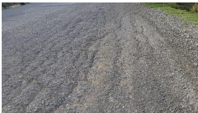
Figura 19: Falla Agregado Pulido, sector Mururco.
