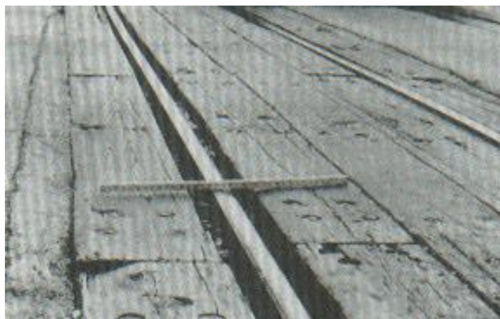
Figura 21: Falla Cruce de Vía Férrea (Manual de Evaluación de Pavimentos).
