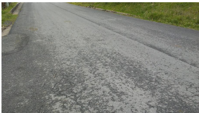
Figura 73: Áreas para ejecución de Tratamientos Superficiales Localizados.
