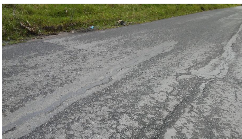
Exudación- Fisuras longitudinales- Intemperismo.
