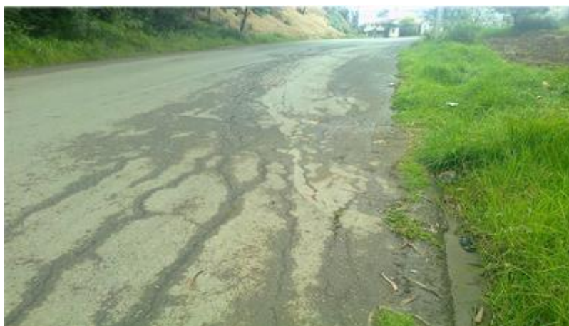
Fisuramiento por Deslizamiento.
