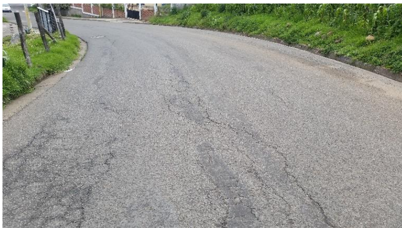
Figura 22: Falla Ahuellamiento, sector Cojitambo.
