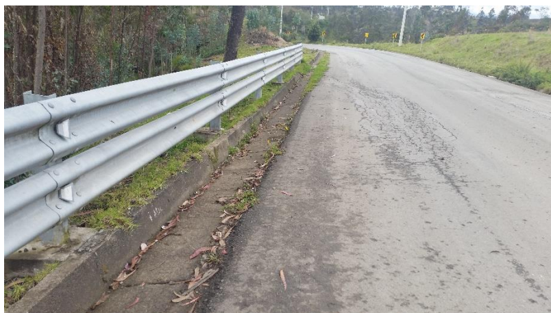
Fisura de deslizamiento.
