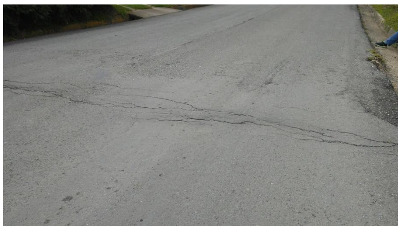
Fisura Longitudinal.
