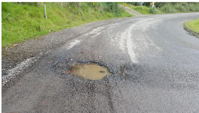
Figura 20: Falla Baches, sector Déleg.
