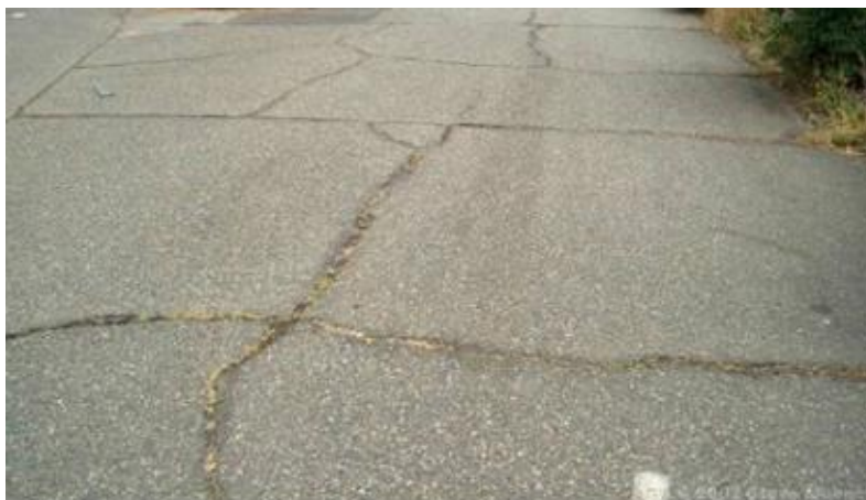
Figura 14: Falla Fisuras de reflexión de junta (Manual de Evaluación de Pavimentos).
