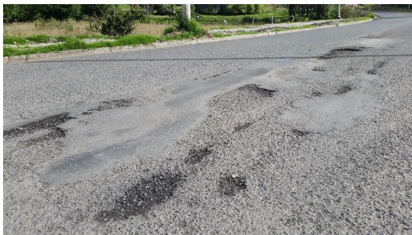
Figura 74: Áreas para ejecución de bacheos superficiales.
