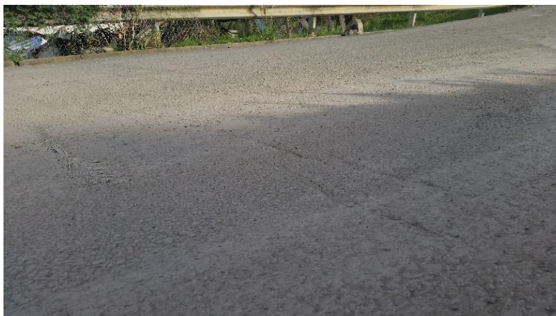
Figura 11: Falla Corrugación. Abs. 5+500 tramo Azogues- Cojitambo.
