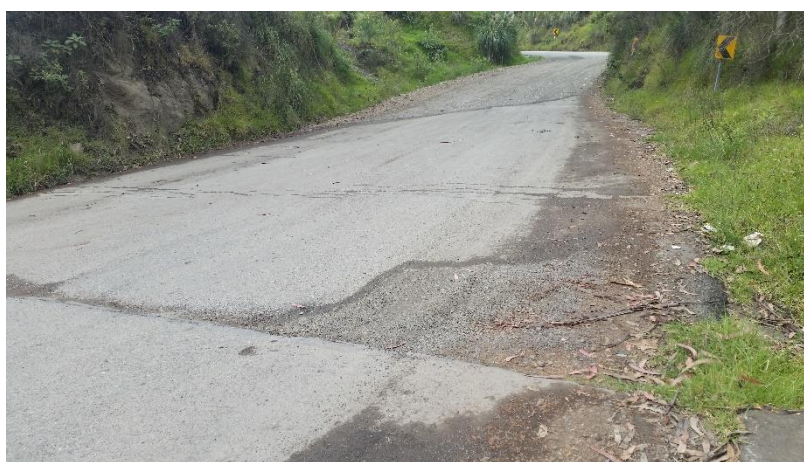
Depresión- Agregado Pulido.
