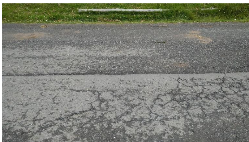
Figura 17: Falla Fisura Longitudinal, Sector La Villa.
