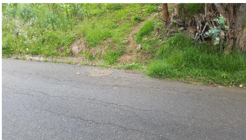
Fisuras longitudinales transversales / Parche.
