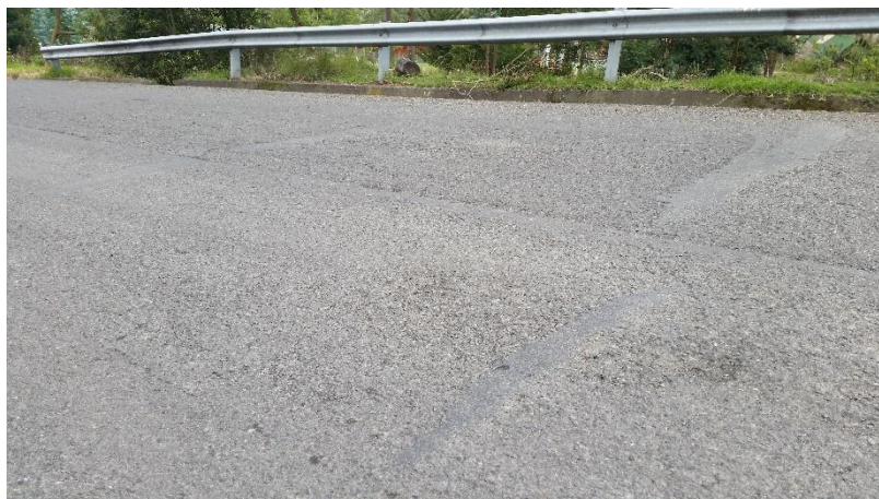
Agregado Pulido- Ahuellamiento.
