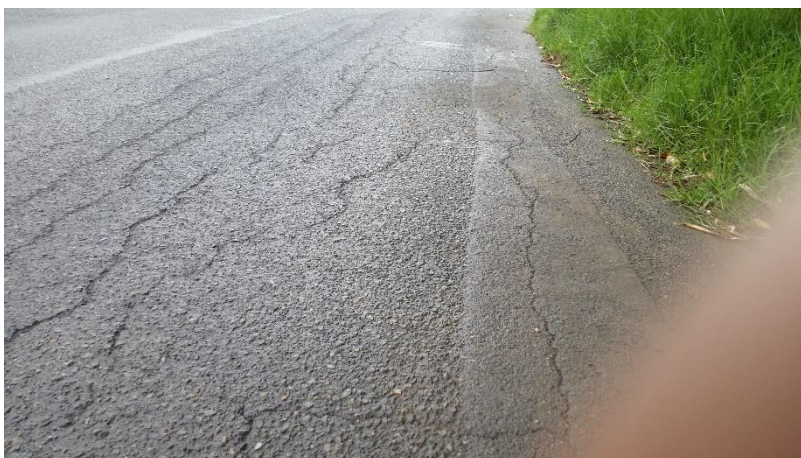
Figura 68: Áreas para ejecución de sellado de grietas.
