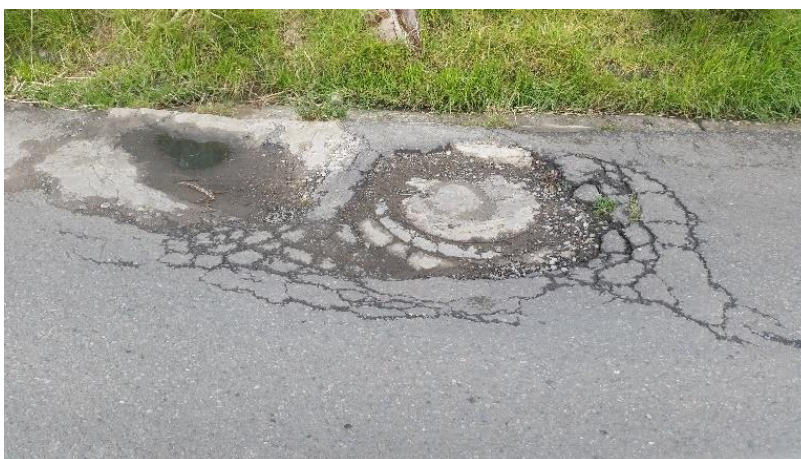
Figura 18: Falla Parches y Parches de cortes utilitarios, tramo Déleg – La Raya.
