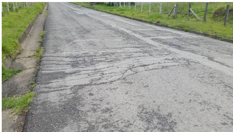
Figura 71: Áreas para ejecución de parches.
