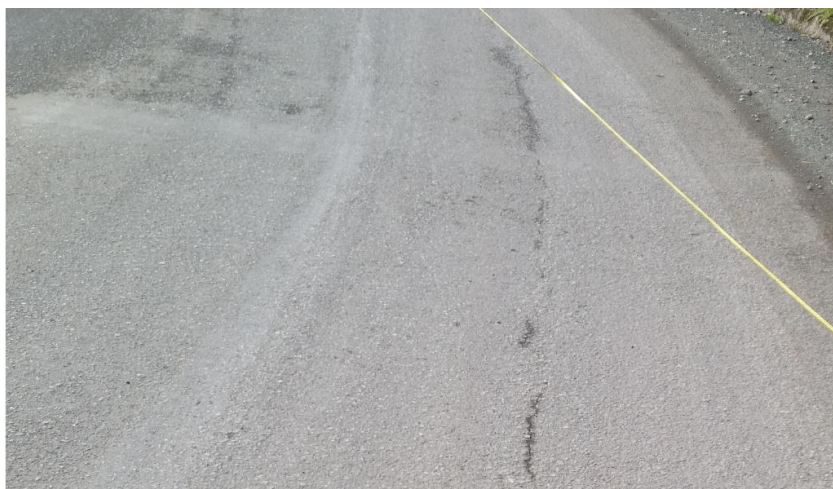
Fisuras Longitudinales - Ahuellamiento.
