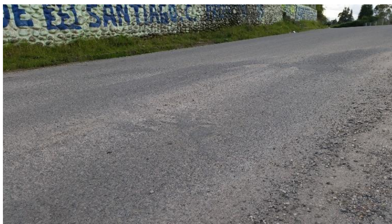
Figura 10: Falla abultamiento y hundimientos. Abs 21 +000, sector La Raya.
