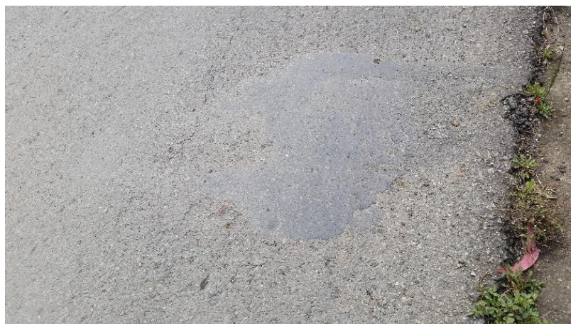
Figura 8: Falla Exudación Abs. 9+530, tramo Cojitambo – Déleg.
