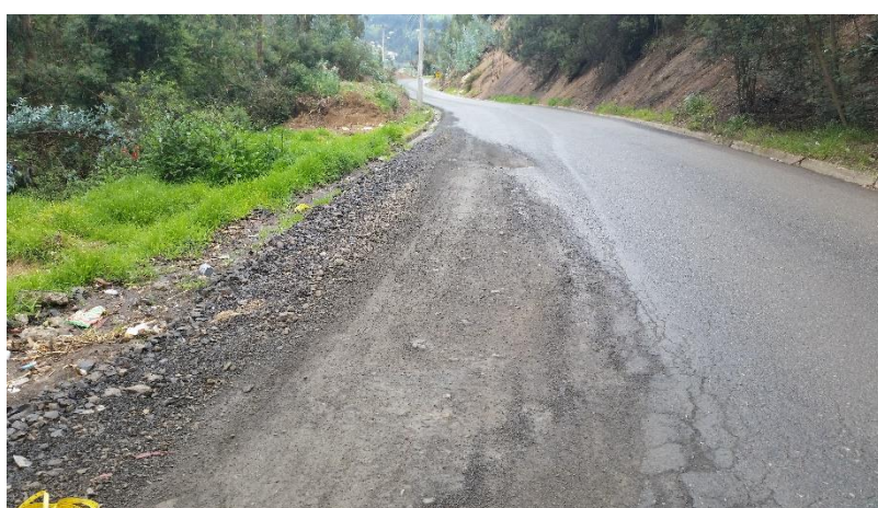
Fisuramiento por Deslizamiento.
