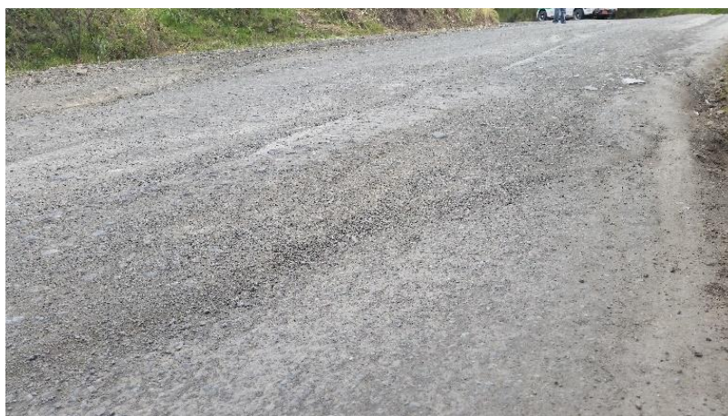
Figura 26: Falla intemperismo y desprendimiento de agregados, sector Pasavalle.
