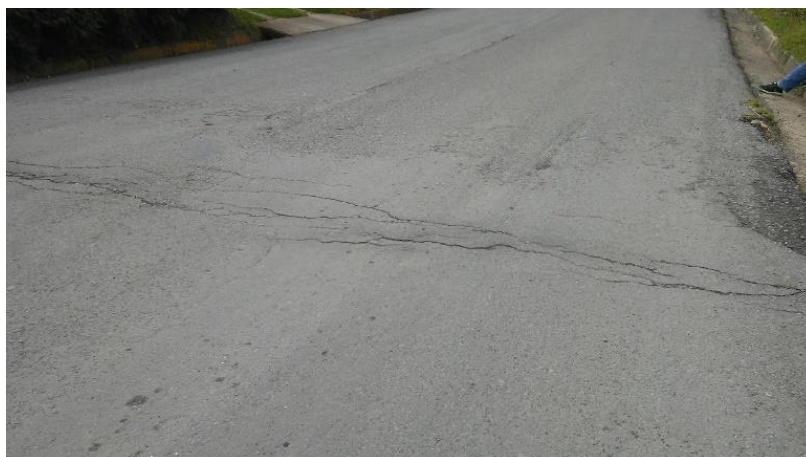
Figura 16: Falla Fisura transversal, sector Pasavalle.
