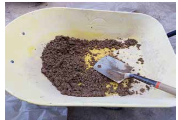
Imagen b8: Sarmiento, I. & Cárdenas, A (2017). Colocación de agua en el suelo para la fabricación de tapiales. [Fotografía]. Cuenca, Ecuador.
