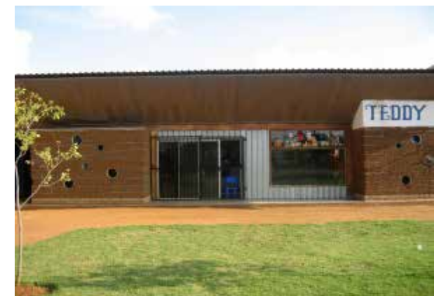
Imagen c30: Kindergarten Baya. Muro de tapial con PVC. Fuente: http://www.lehmt-nerde.at/en/projects/project.php?pid=52
