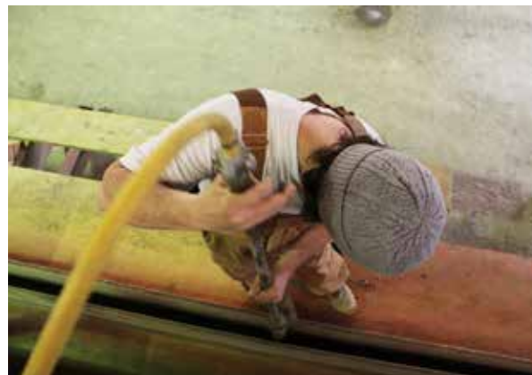
Imagen c13: Colocacion de tierra en el encofrado. Fuente: https://www.rammedearthworks.com/blog/2016/1/30/pre-cast-rammed-earth
