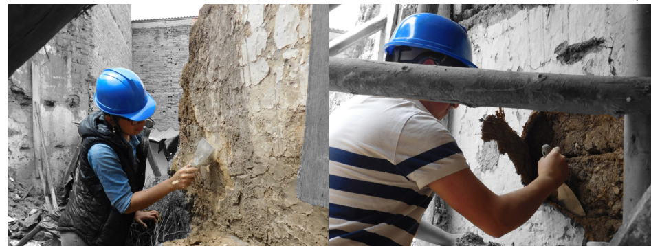
Imagen 44. Extracción de adobes edificación 2 Propio
