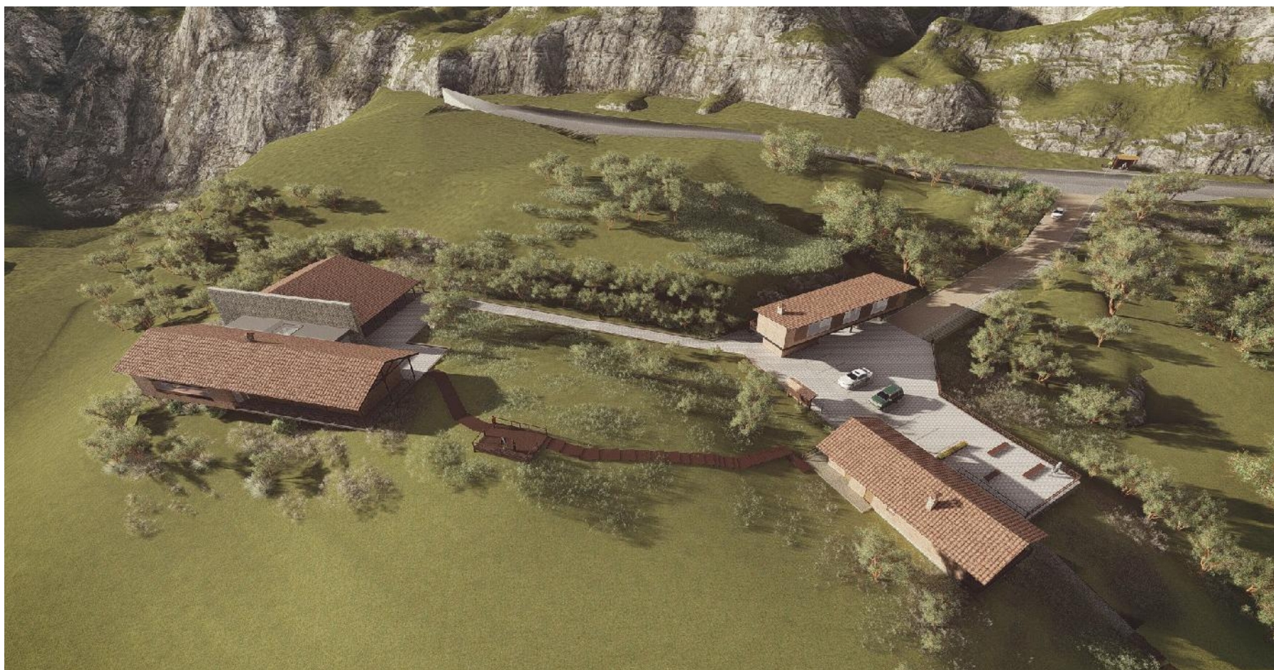
Infraestructura en la Zona Toreadora
