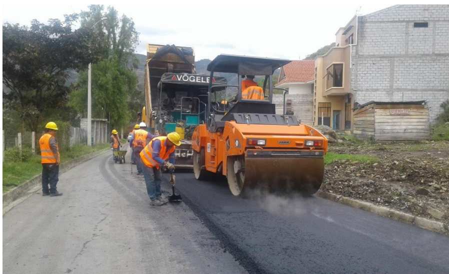
Figura 3-4: Compactación con rodillo tándem de 8 toneladas.
