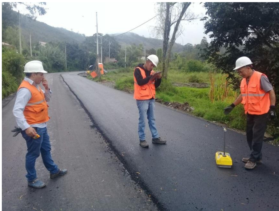
Figura 4-5: Control de densidad en tendido de asfalto.
