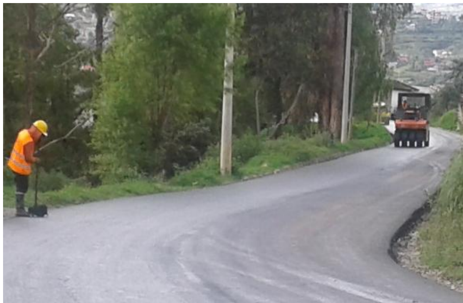
Figura 3-5: Acabado y compactación con rodillo neumático.
