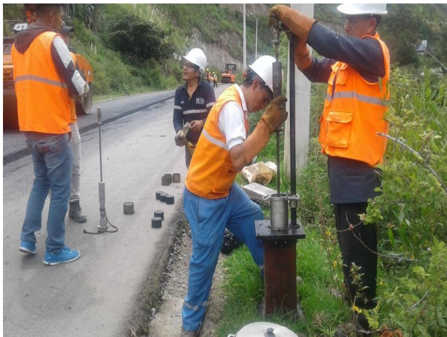
Figura 4-6: Elaboración de briqueta en campo.
