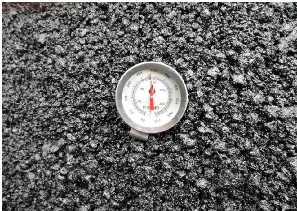
Figura 4-4: Control de temperatura previo a la compactación.
