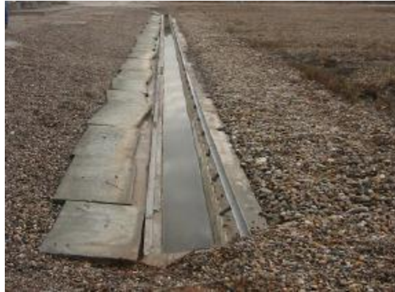
Ilustración 26 Canal de vertido en un humedal de flujo horizontal Fuente: Depuración con Humedales Construidos, Guía práctica de diseño, construcción y explotación de sistemas de humedales artificiales, (García & Corzo, 2008).
