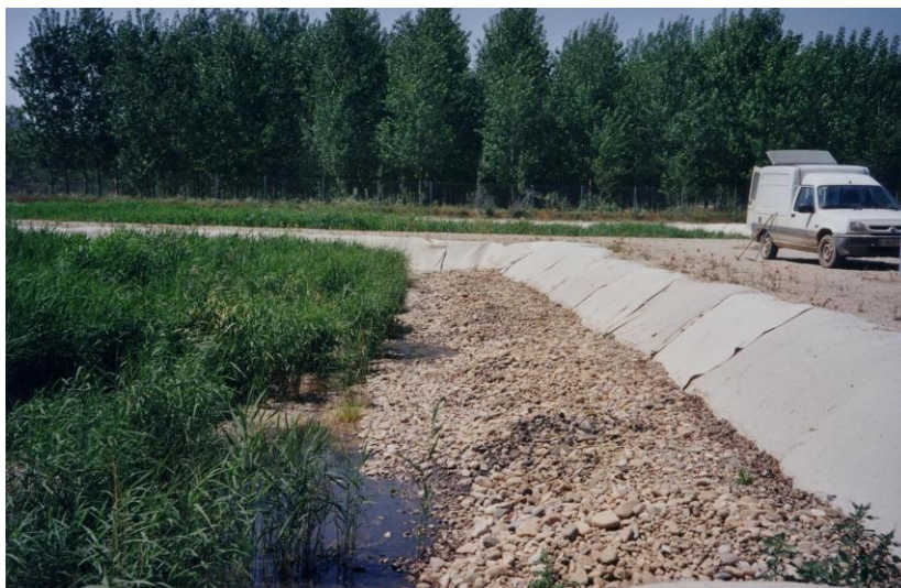
Ilustración 27 Franja de material granular de gran tamaño en la zonas de entrada al humedal de flujo subsuperficial horizontal. Fuente: Depuración con Humedales Construidos, Guía práctica de diseño, construcción y explotación de sistemas de humedales artificiales, (García & Corzo, 2008).
