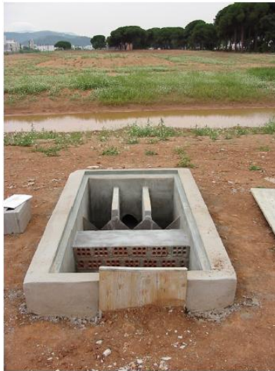
Ilustración 24 Arqueta de repartición durante su construcción. Fuente: Depuración con Humedales Construidos, Guía práctica de diseño, construcción y explotación de sistemas de humedales artificiales, (García & Corzo, 2008).
