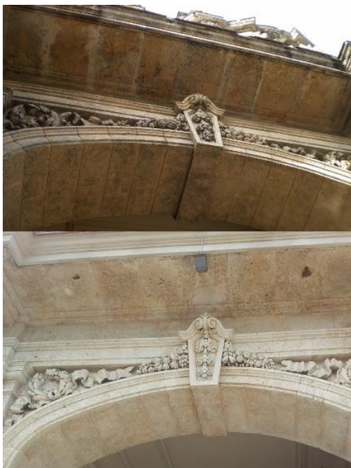
Figura 7: Limpieza de la piedra antes y después
