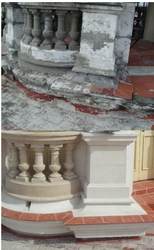
Figura 8: Estado de daños y restauración
