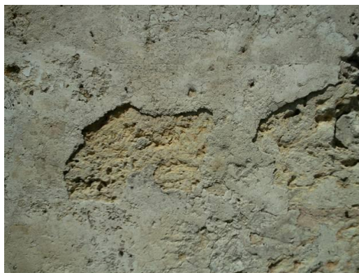
Figura 5: Pérdida del revestimiento. Fuente: Sergio R. Arencibia, 2015.
