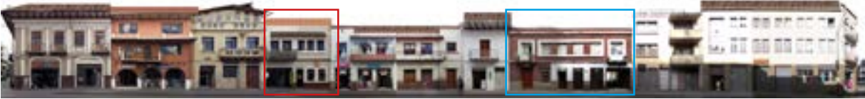
Figura 146. Tramo Tarqui, entre Sucre y Presidente Córdova Fuente: Autora y colaboración de practicantes
