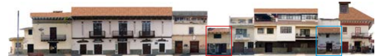
Figura 154. Tramo Av. 12 de Abril, entre Av. Loja y Calle Del Farol Fuente: Autora y colaboración de practicantes
