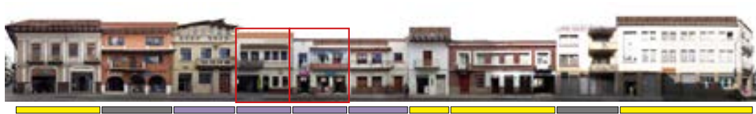
Figura 112. Tramo Tarqui, entre Sucre y Presidente Córdova Fuente: Autora y colaboración de practicantes
