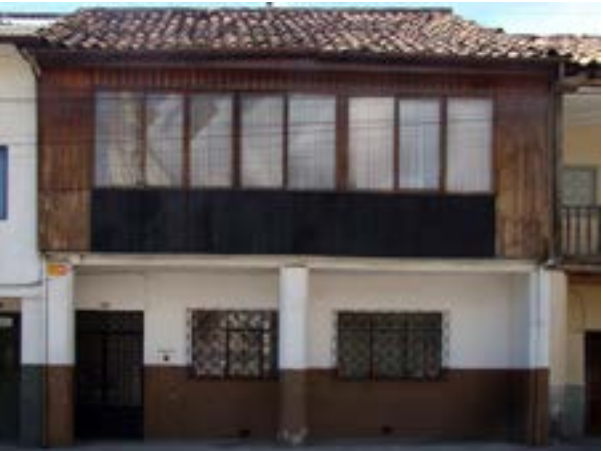
Figura 54. Inmueble 0802016003, Barrio de San Roque Fuente: Autora
