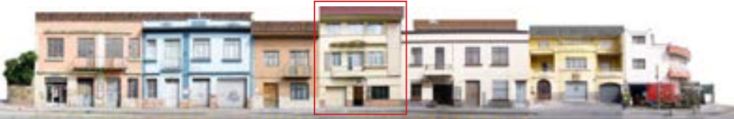
Figura 148. Tramo Av. Loja, entre Galápagos y Pastaza Fuente: Autora y colaboración de practicantes
