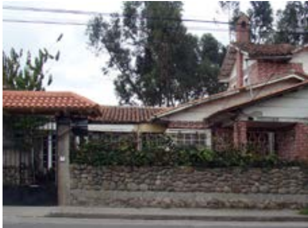
Figura 58. Inmueble 0801009062, Barrio de San Roque Fuente: Autora
