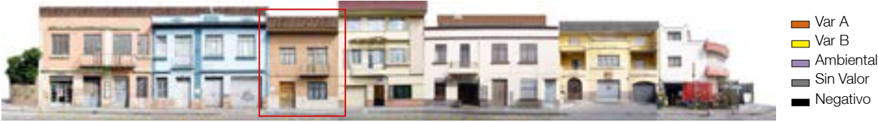
Figura 123. Tramo Av. Loja, entre Galápagos y Pastaza Fuente: Autora y colaboración de practicantes
