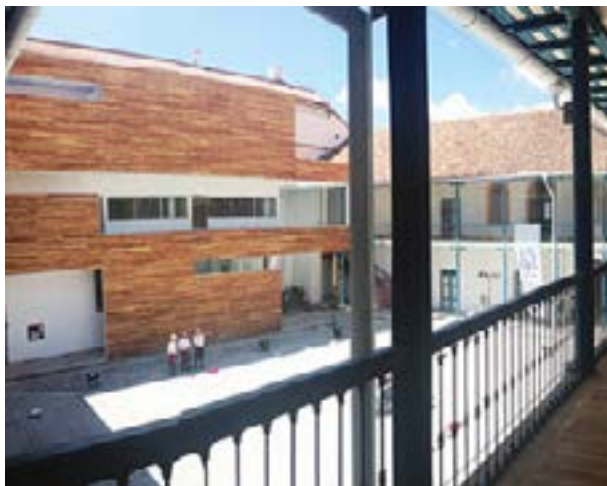
Figura 25. Proyecto de Restauración del Inmueble conocido como Escuela Central, Cuenca Fuente: Restauración de la Escuela Central de Niñas la Inmaculada, GAD Municipal de Cuenca
