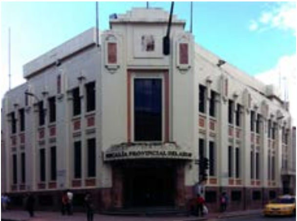
Figura 4. Edificio sede del Banco Central, actual Fiscalía del Azuay. ejemplo de la tendencia art decó en fachadas Fuente: Autora
