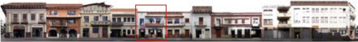
Figura 170. Tramo Tarqui, entre Sucre y Presidente Córdova Fuente: Autora y colaboración de practicantes
