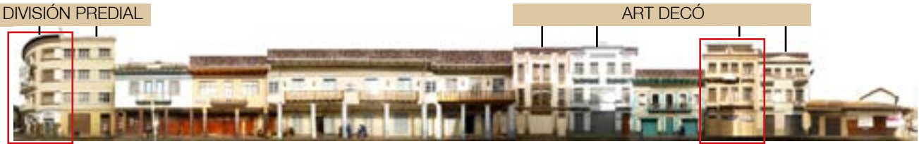
Figura 91. Tramo calle General Torres, entre Sucre y Presidente Córdova Fuente: Autora y colaboración de practicantes
