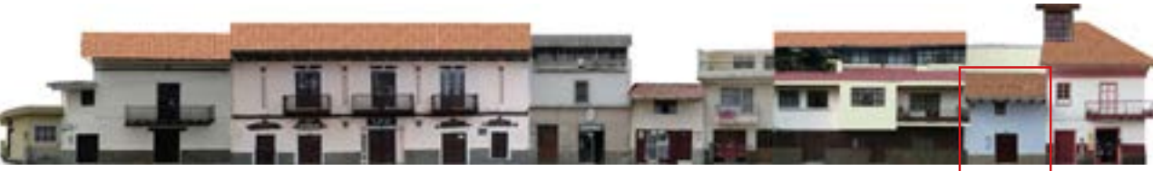
Figura 172. Tramo Av. 12 de Abril entre Av. Loja y calle Del Farol Fuente: Autora y colaboración de practicantes
