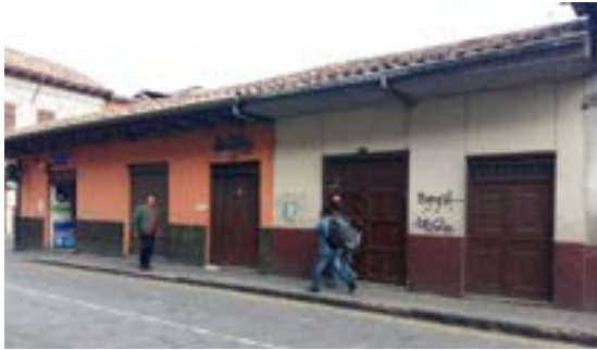
Figura 71. Inmuebles 0102041034 y 0102041033 Fuente: Autora
