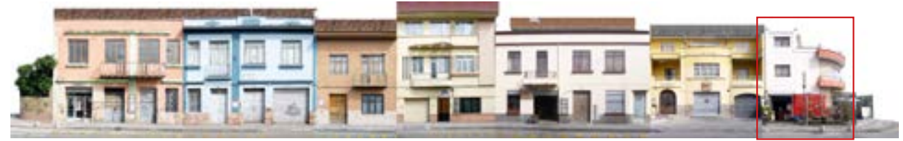
Figura 141. Tramo Av. Loja, entre Galápagos y Pastaza Fuente: Autora y colaboración de practicantes
