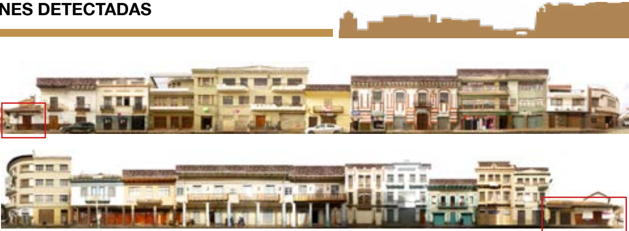
Figura 85. Tramos calle Sucre y General Torres, Manzana 0102041 Fuente: Autora y colaboración de practicantes
