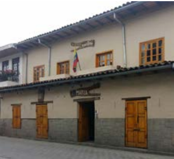
Figura 29. Alteraciones detectadas en el predio de clave catastral 0203019005, ubicado en la calle Hno. Miguel 4-79 entre Honorato Vásquez y Calle Larga. Fuente: Inventario 1999 y Autora
