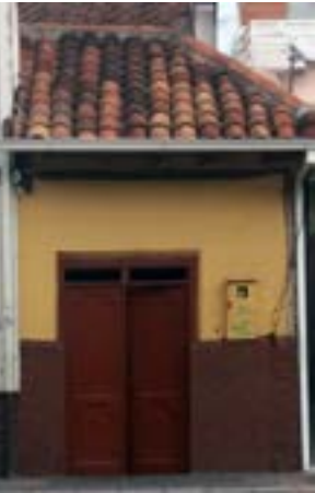
Figura 52. Inmueble 0801007008, Barrio de San Roque Fuente: Autora
