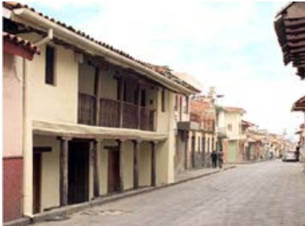
Figura 2. Casa de las Posadas, arquitectura colonial Fuente: Diario La Tarde. Obtenido de: http://www.latarde.com.ec/2016/04/11/casa-de-las-posadas-un-lugar-de-paz/
