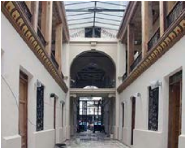
Figura 24. Proyecto de Restauración del Inmueble conocido como Pasaje León, Cuenca Fuente: http://www.cuenca.gob.ec/?q=content/recuperaci%C3%B3n-del-pasaje-le%C3%B3n-con-un-avance-del-18-y-Autora
