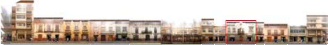
Figura 79. Tramo Tarqui, entre Sucre y Presidente Córdova Fuente: Autora y colaboración de practicantes
