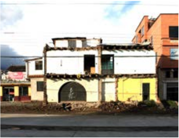
Figura 12. Destrucción del patrimonio cultural edificado en la Av. Ordóñez Lazo, 2016 Fuente: Dirección de Áreas Históricas y Patrimoniales, GAD Municipal de Cuenca
