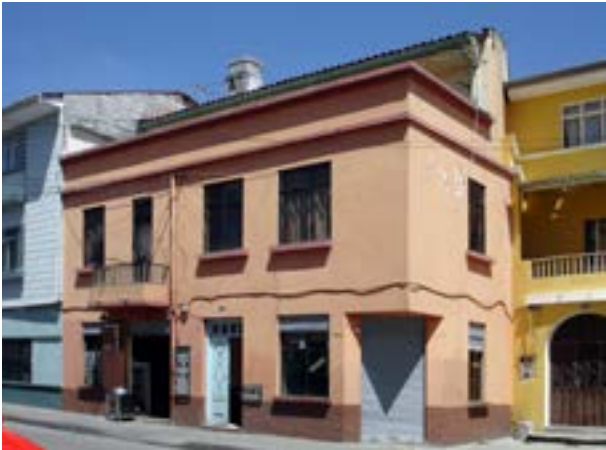
Figura 56. Inmueble 0801035011, Barrio de San Roque Fuente: Autora
