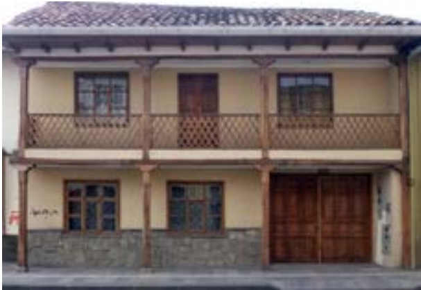
Figura 55. Inmueble 0802016018, Barrio de San Roque Fuente: Autora
