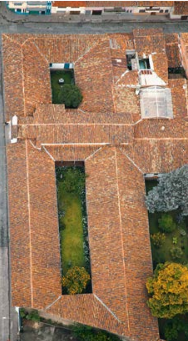
Figura 50. Tipología de Implantación y Quinta Fachada Fuente: Dirección de Áreas Históricas y Patrimoniales, GAD Municipal de Cuenca
