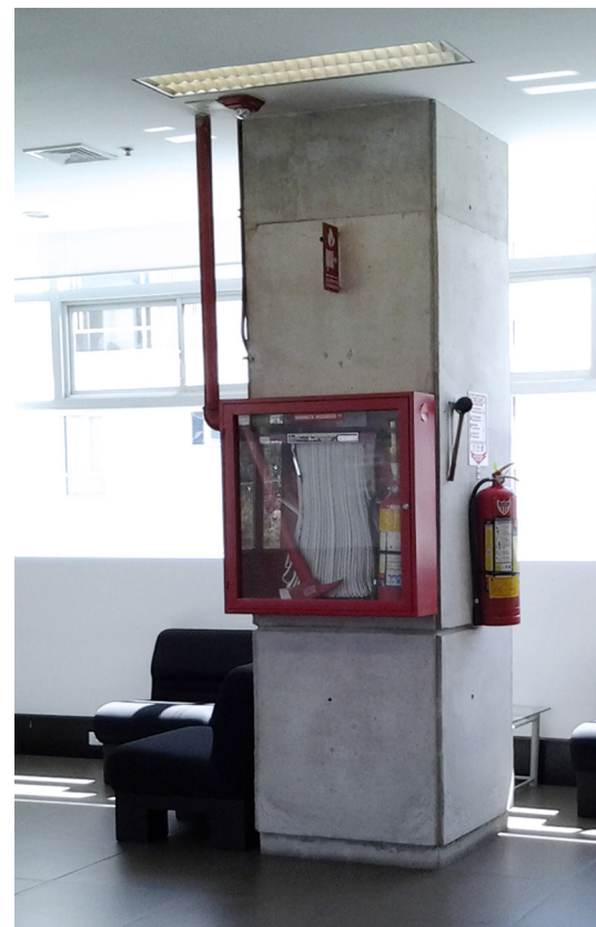
Ilustración 59. Sistema de protección contra incendios. Biblioteca. FLACSO-Ecuador.
