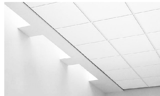
Techo suspendido desmontable de escayola
