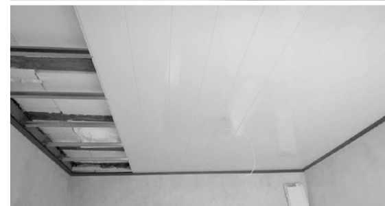
Techo suspendido desmontable de PVC
