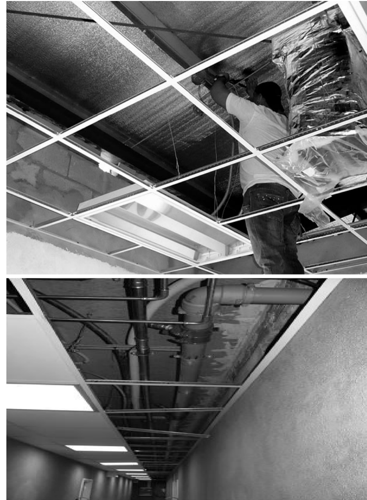
Ilustración 75. Disposición de la canalización en cielo raso desmontable.
