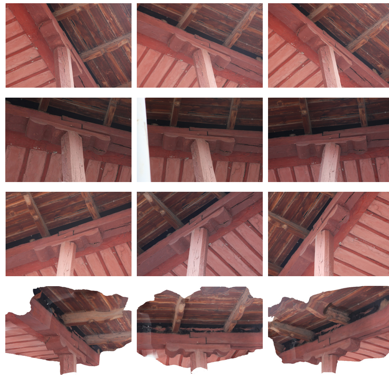
FIG. 1.13: Procesamiento fotogramétrico de imágenes digitales a través del software Photoscan. Fuente: Opción Conservación 2014-2015.
