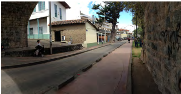
Figura. 4.161: Corredor del Puente Roto vista al sureste. FUENTE: Elaboración propia.
