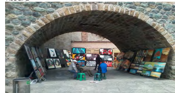
Figura. 4.158: Arco del Puente Roto vista al sureste. FUENTE: Elaboración propia.
