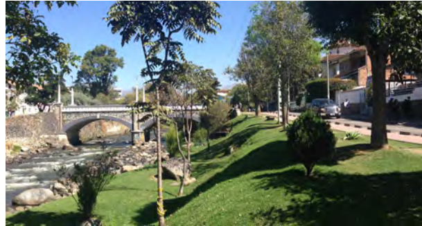
Figura. 4.160: Corredor del Puente Roto vista 2 al noroeste. FUENTE: Elaboración propia.
