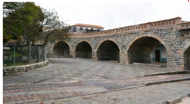
Figura 3.26: Puente Roto. Fuente: Elaboración propia.
