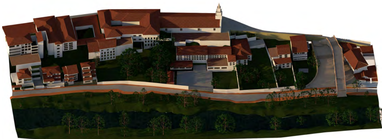
Figura 3.67: Soleamiento, 8 junio 5 pm. (sector Puente Roto)
