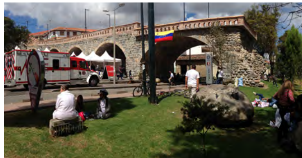
Figura. 4.162: Corredor y Puente Roto vista al este. FUENTE: Elaboración propia.
