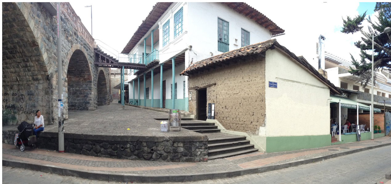
Figura 1.4: Puente Roto. Fuente: Elaboración propia.
