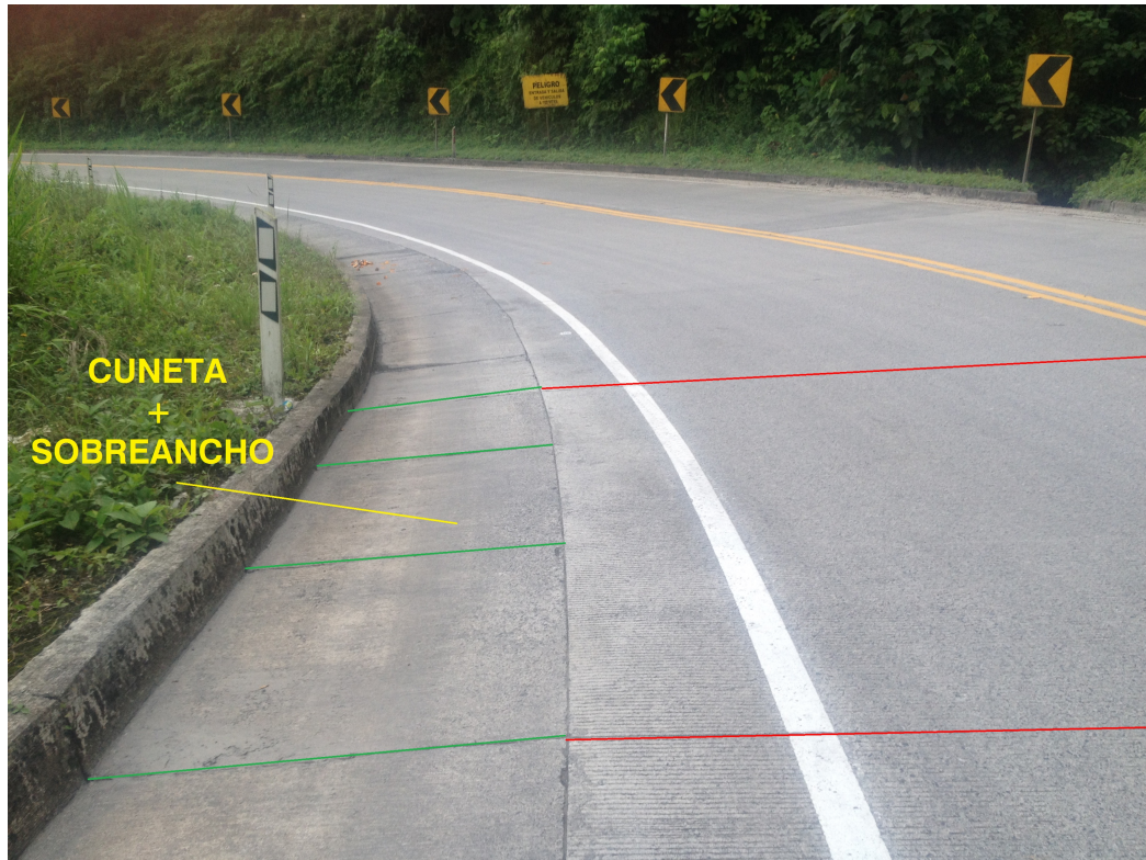
Figura 37: Disposición de juntas transversales en tangentes.
