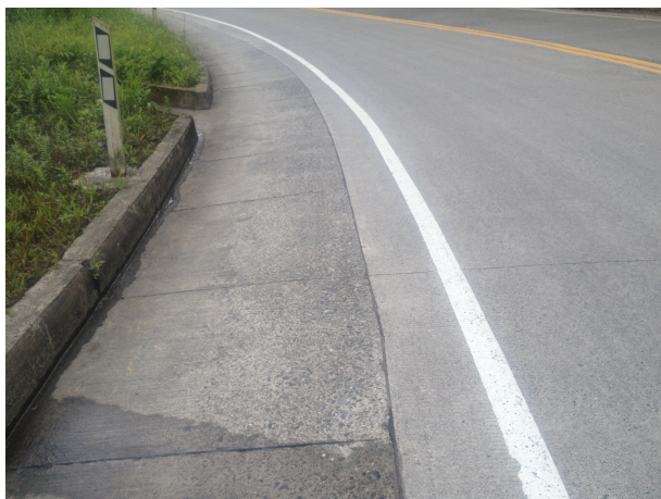
Pulimiento de superficie en zona de sobreancho
