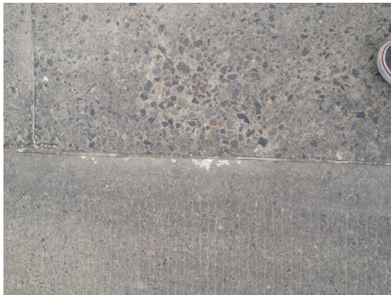
Desgaste mayor zona sobreancho cuneta
