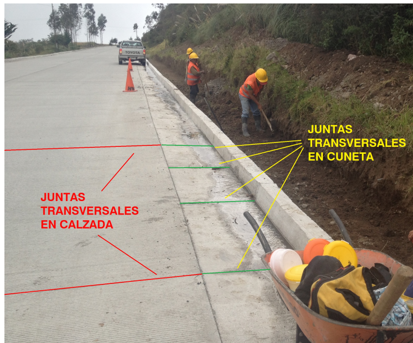
Figura 38: Disposición de juntas transversales en curvas.
