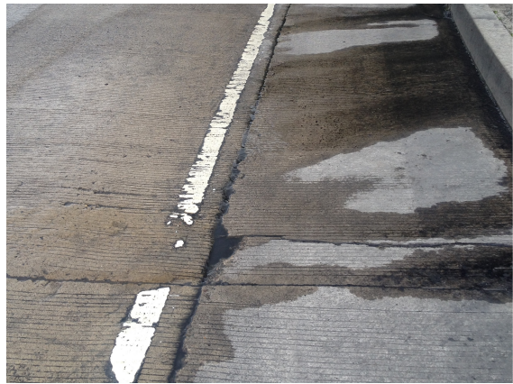
Despostillamiento sobreancho
