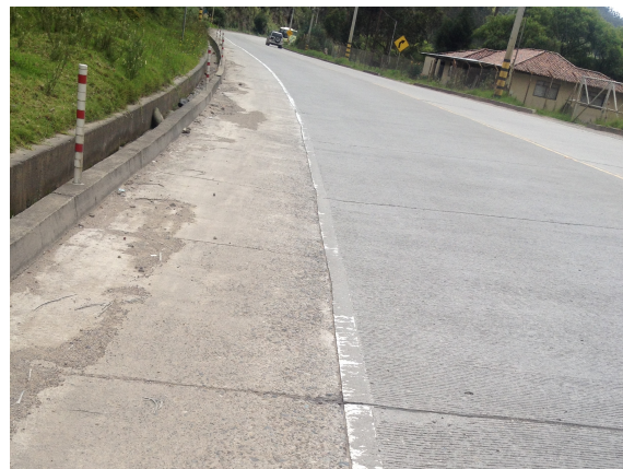
Pulimiento zona de sobreancho
