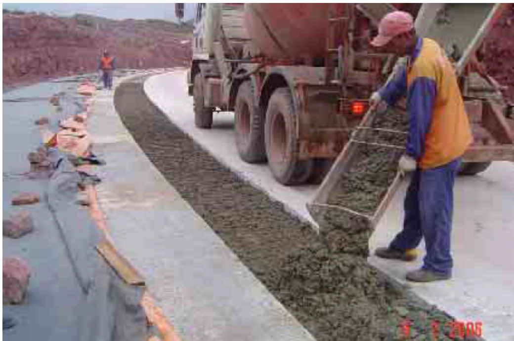
Figura 2: Construcción de sobreanchos en el eje de la vía. [10].
