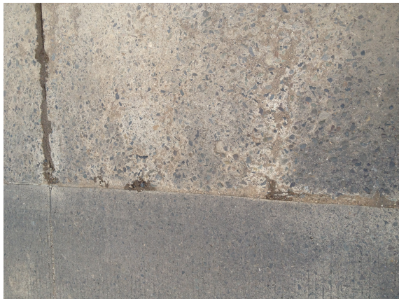
Pulimiento diferente calzada y cuneta
