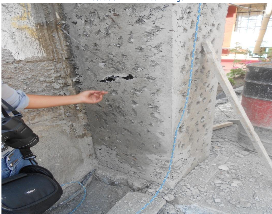
Ilustración 22 Falla de hormigón
