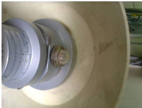
Figura 4.35: Material sintético para la tropicalización en los sensores.
