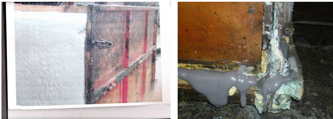
Fotografía N° 5: Estado Actual de los Moldes de Espuma
