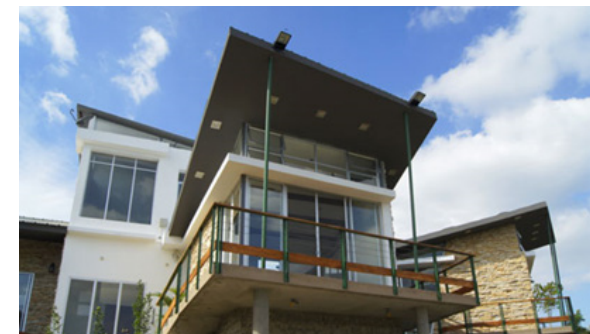
Foto 2.6. Aleros grandes en fachadas de vidrio.
