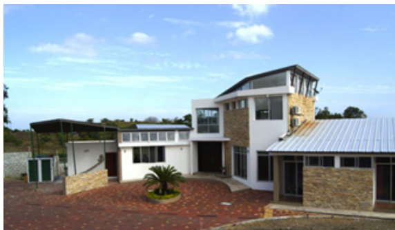
Foto 2.4. Fachada más larga orientada oeste - este.
