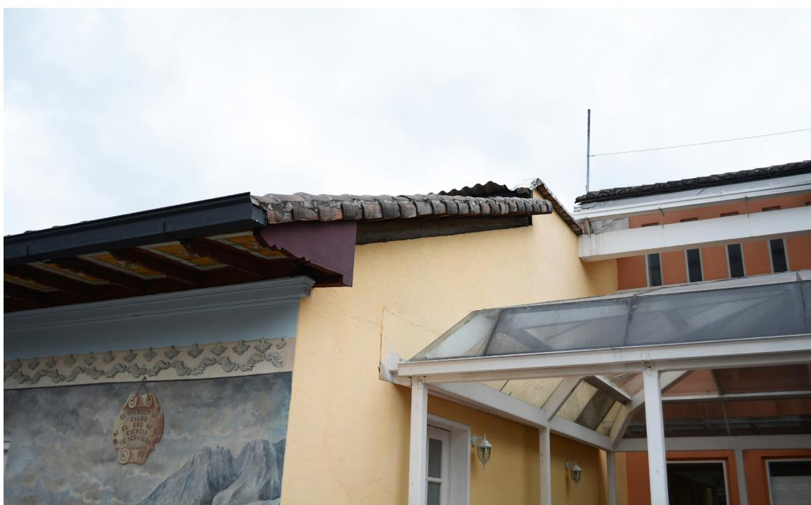
Figura 47: Unión de cubiertas bloque lateral y bloque principal. Casa Tres Manuela (2015)
