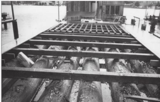
Imagen 45: Sistema constructivo vivienda flotante, Lago Union, USA, 1900
