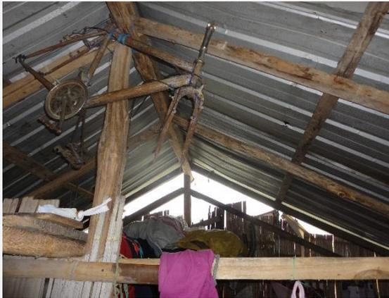
Imagen 95: Uso de planchas de zinc como recubrimiento de la cubierta a dos aguas
