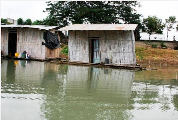
Imagen 80: Uso de materiales reciclados para completar la estructura de la vivienda.
