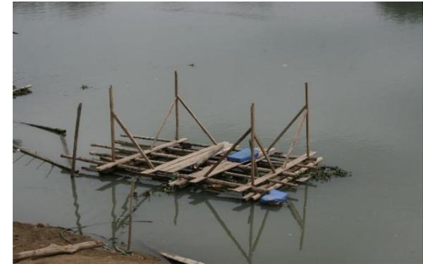
Imagen 91: Proceso de entramado estructural de la base y pilares de la vivienda
