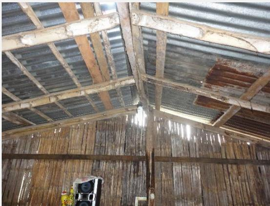
Imagen 96: Estructura de la cubierta, realizada con madera y caña en disposición longitudinal
