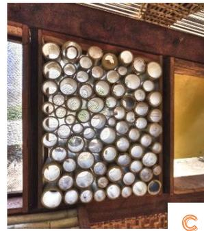
Imagen 150: Detalle para ventoleras
