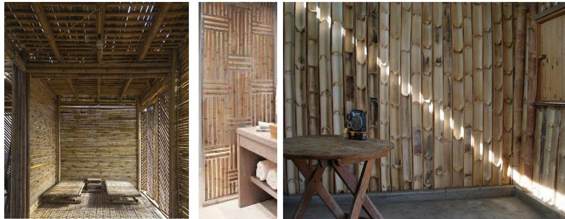
Imagen 141, 142, 143: Detalle de los distintos tipos de orientación de la caña guadua para las paredes de la vivienda.
