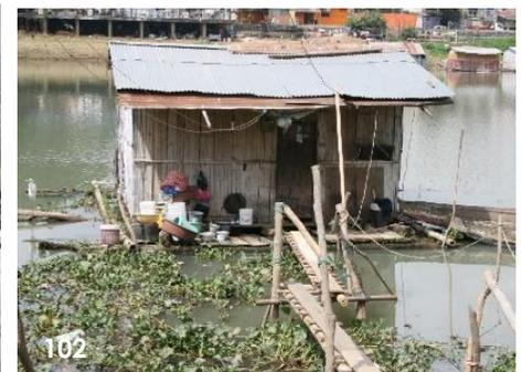
Es decir, se observa una clara supremacía de daños vinculados a la degradación del material, desprendimiento y manchas y eflorescencias debido a la presencia de humedad, tanto en la estructura de piso (balsa y laurel) como de recubrimiento de piso y pared (laurel, marañón, fruta de pan, etc.), degradación de material debido a la presencia de polillas en la estructura de madera en pisos, paredes y cubierta, degradación de material de revestimiento en cubierta (zinc) debido a la oxidación.
