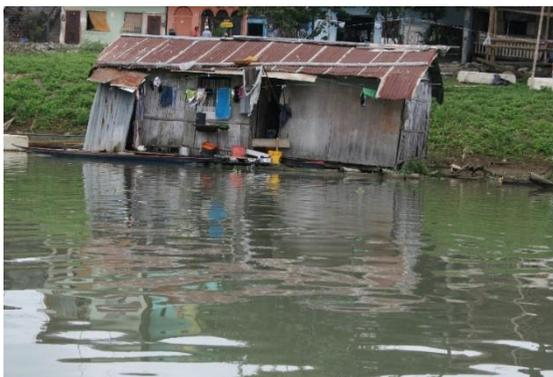
Imagen 94: Paredes hechas de tableros de plywood combinadas con caña
