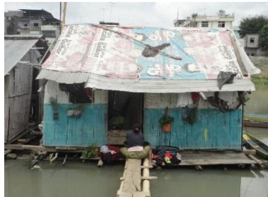
Imagen 103: Incorporación de plástico en cubiertas.
