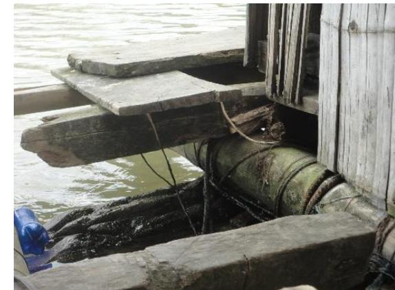
Imagen 88: Amarre de componentes de la base, mediante cabos.
